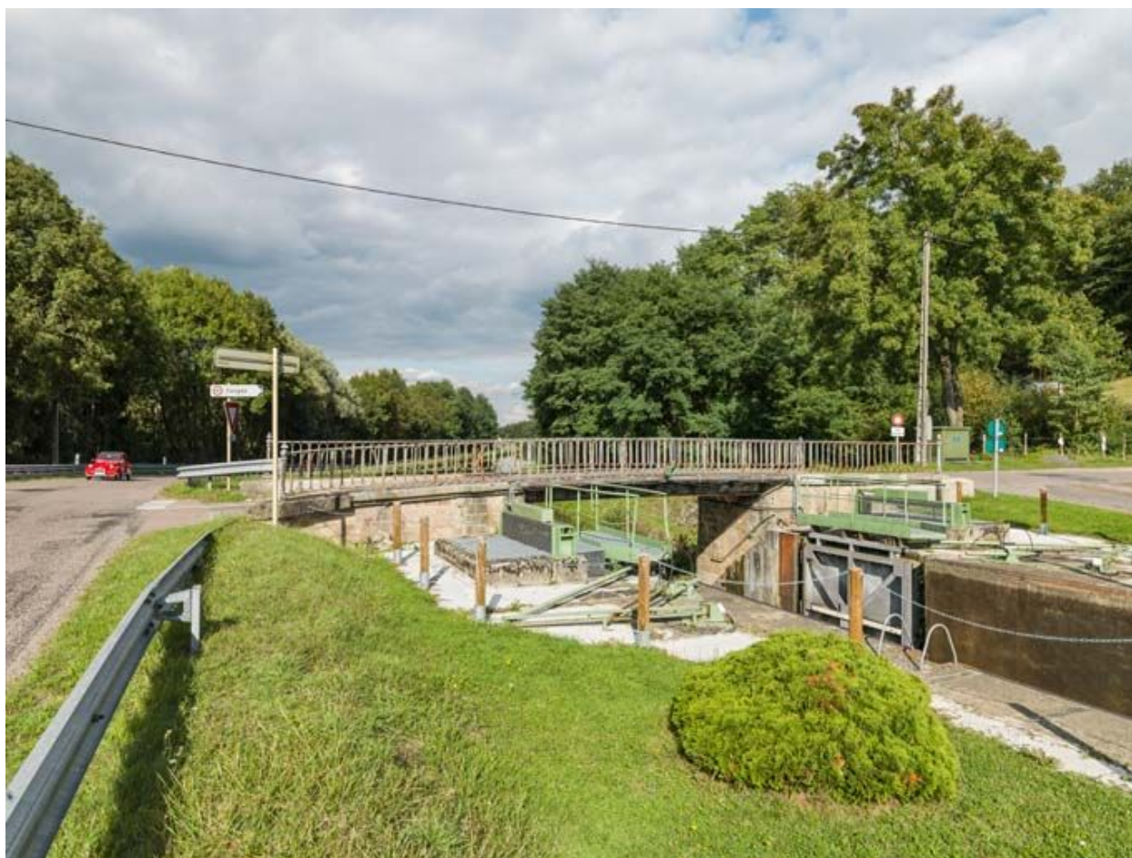
Vue d'ensemble du pont.
