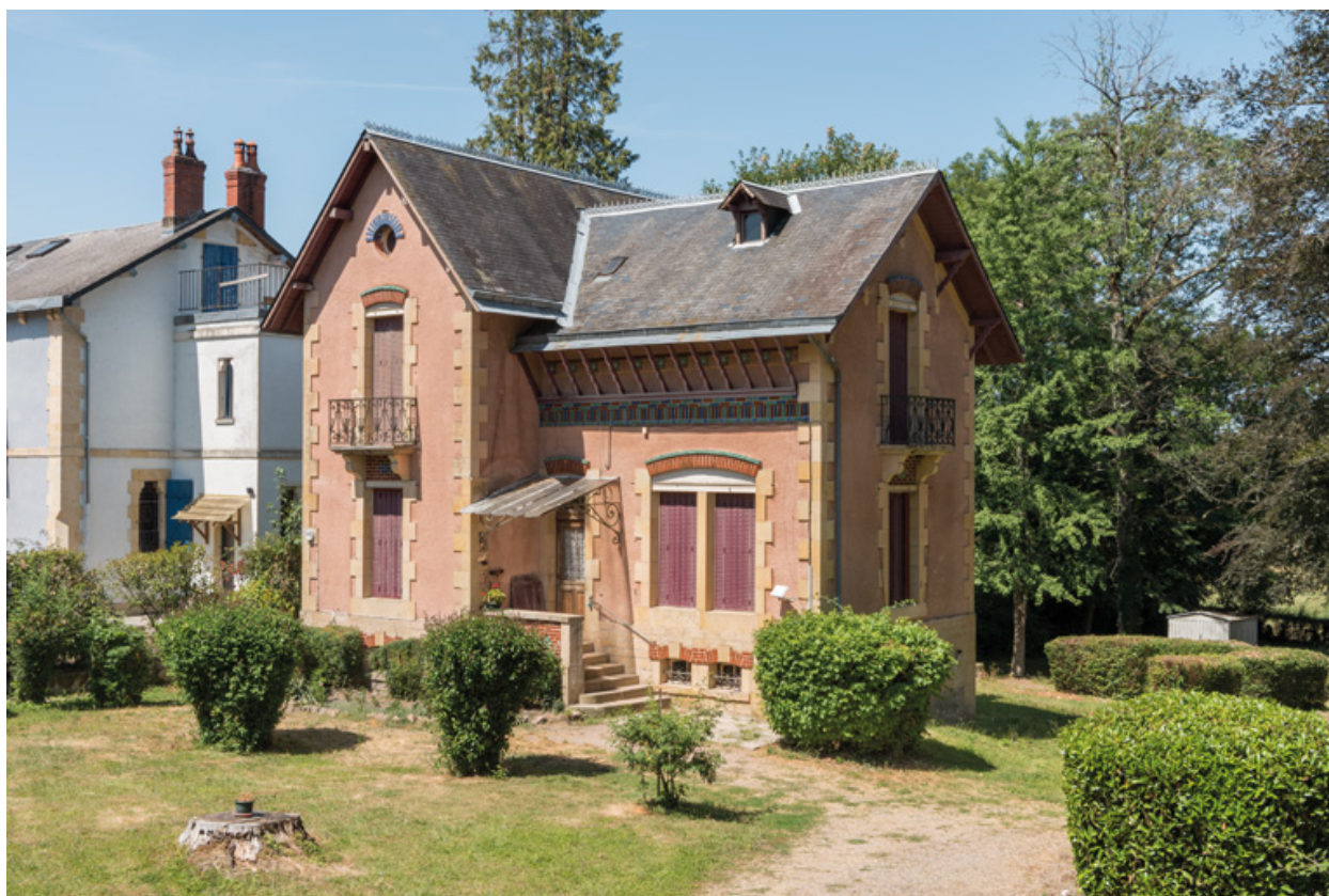
Façade sur l'avenue de Rémilly.
