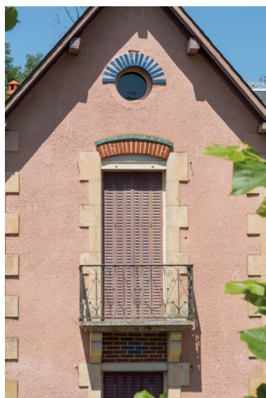
Mur-pignon, détail des ouvertures, vue de face. Phot. Pierre-Marie Barbe-Richaud IVR26_20195800480NUC4A
