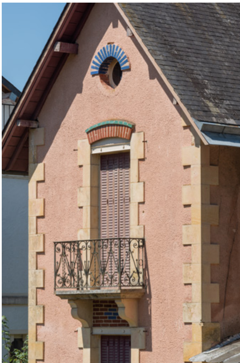
Mur-pignon, détail des ouvertures, vue de trois-quarts.
