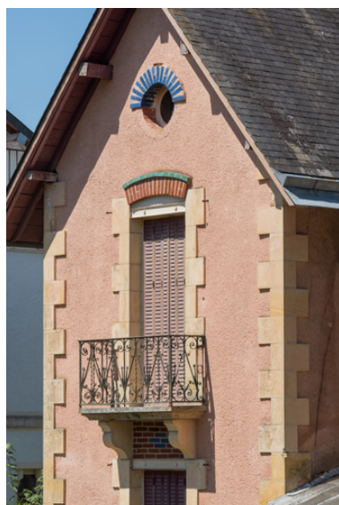
Mur-pignon, détail des ouvertures, vue de trois-quarts. Phot. Pierre-Marie Barbe-Richaud IVR26_20195800479NUC4A
