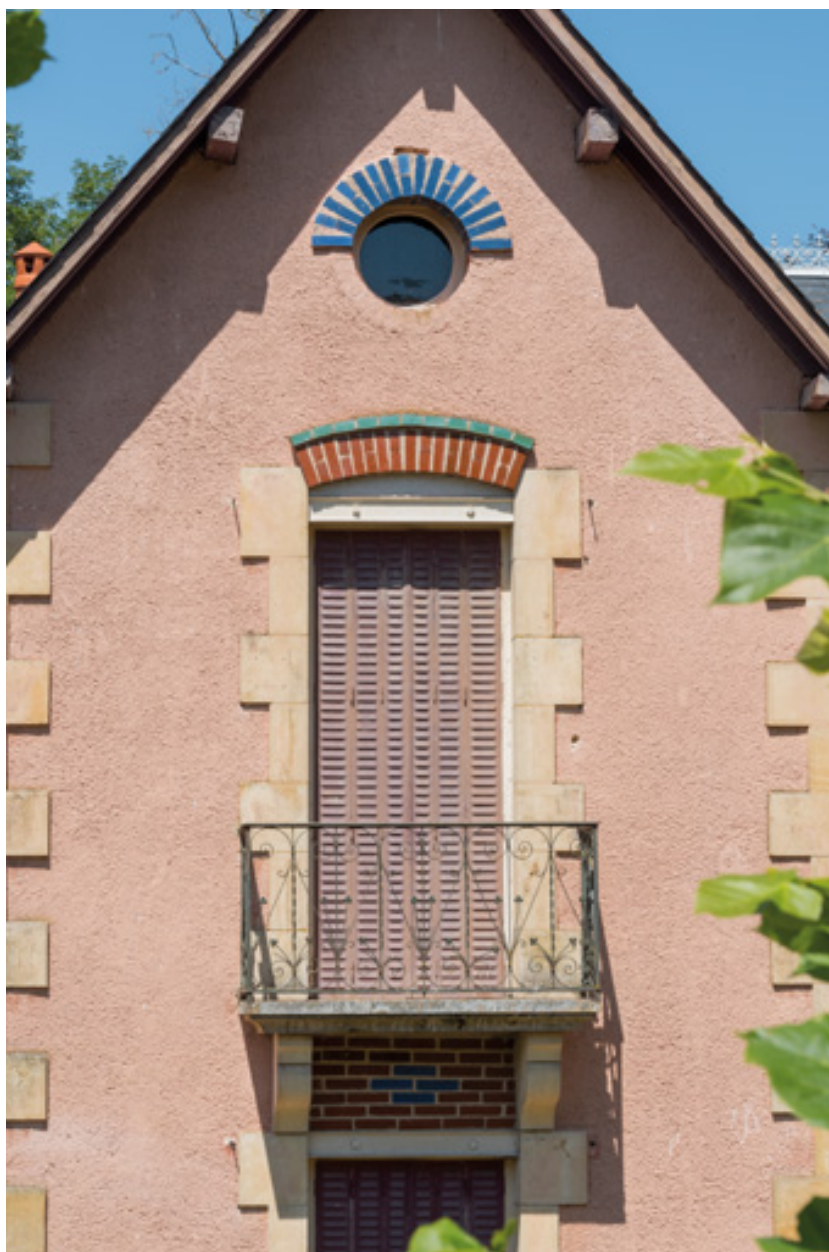
Mur-pignon, détail des ouvertures, vue de face.
