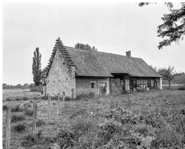
Façade antérieure et pignon gauche. Phot. Yves Sancey IVR43_19843900034X
