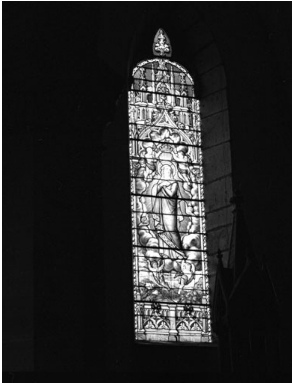
Baie 0 : vue d'ensemble.
