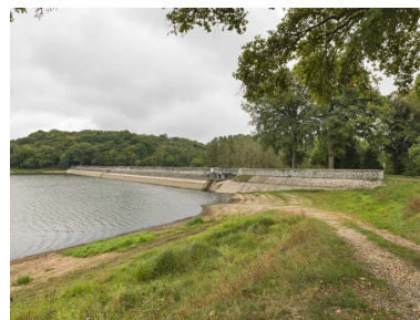
Vue de la digue. Phot. Pierre-Marie Barbe-Richaud IVR26_20177100329NUC2A
