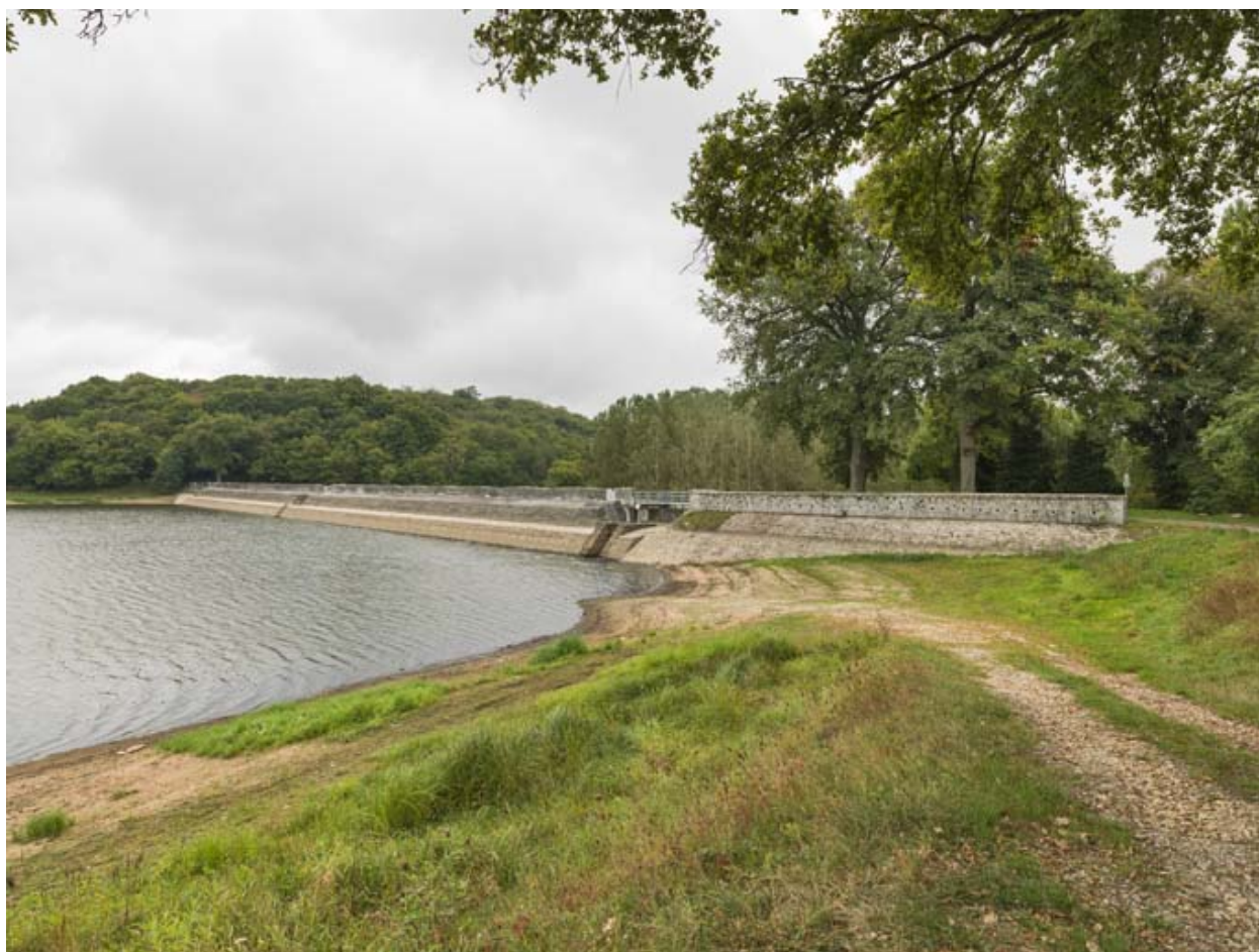
Vue de la digue.
