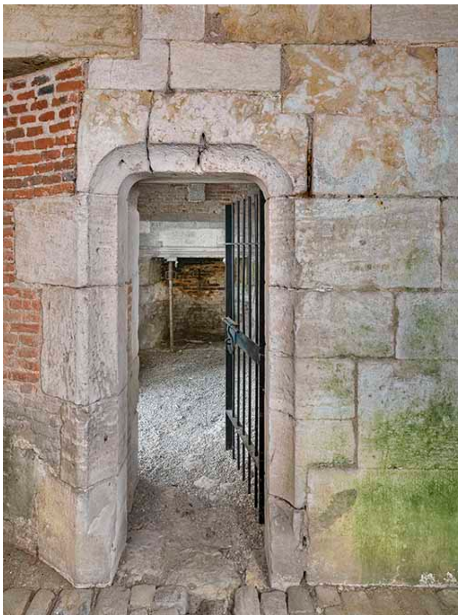
Pavillon d'entrée : entrée du corps de garde.
