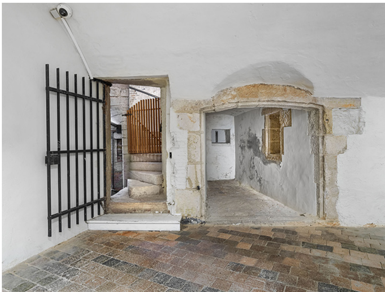
Tour Notre-Dame : porte d'accès au premier niveau.
