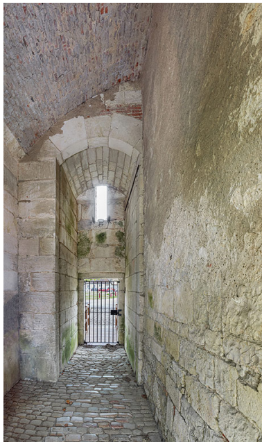
Pavillon d'entrée : passage piéton. Phot. Thierry Kuntz IVR26_20242100243NUC4A
