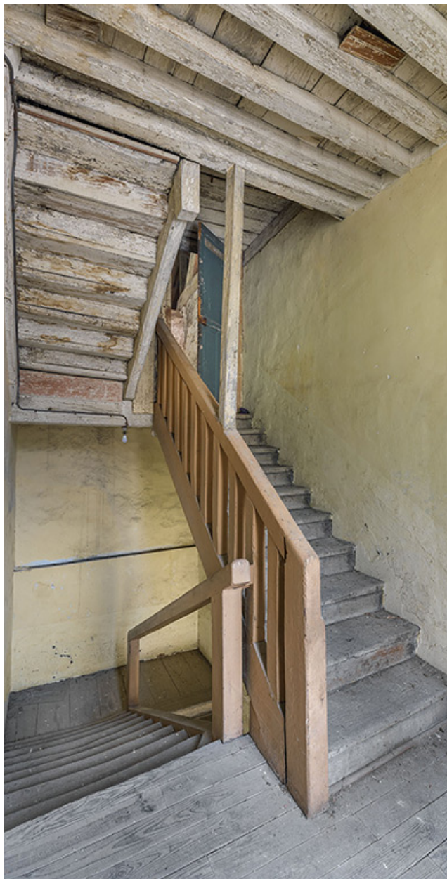
Caserne Vauban : cage d'escalier au 1er étage.
