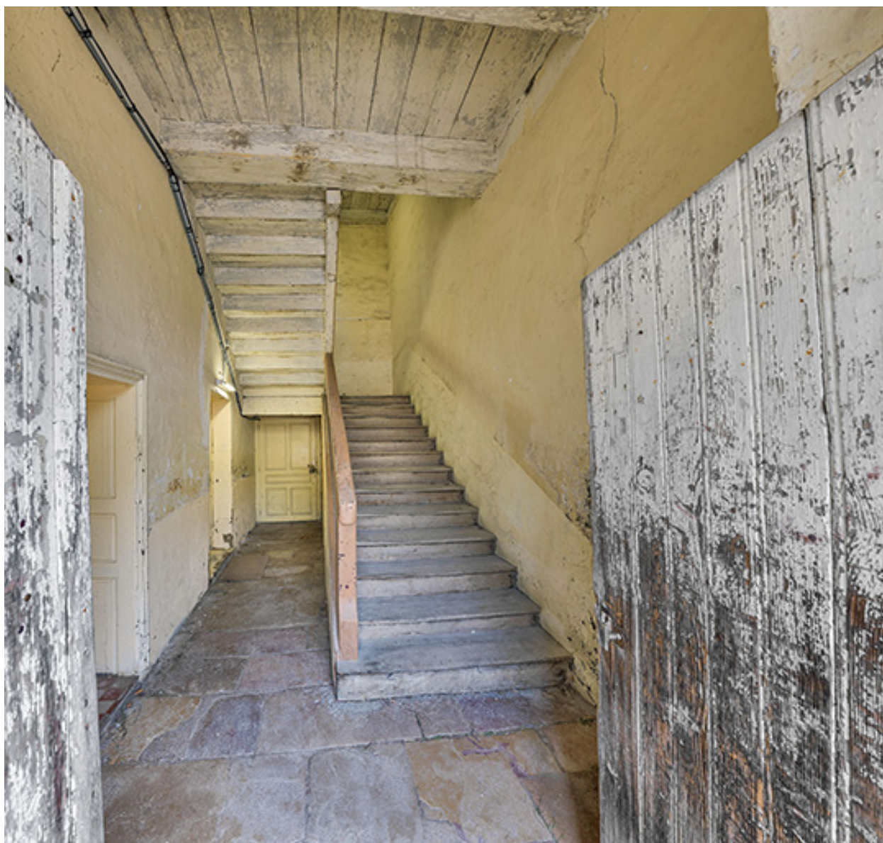
Caserne Vauban : cage d'escalier au rez-de-chaussée.
