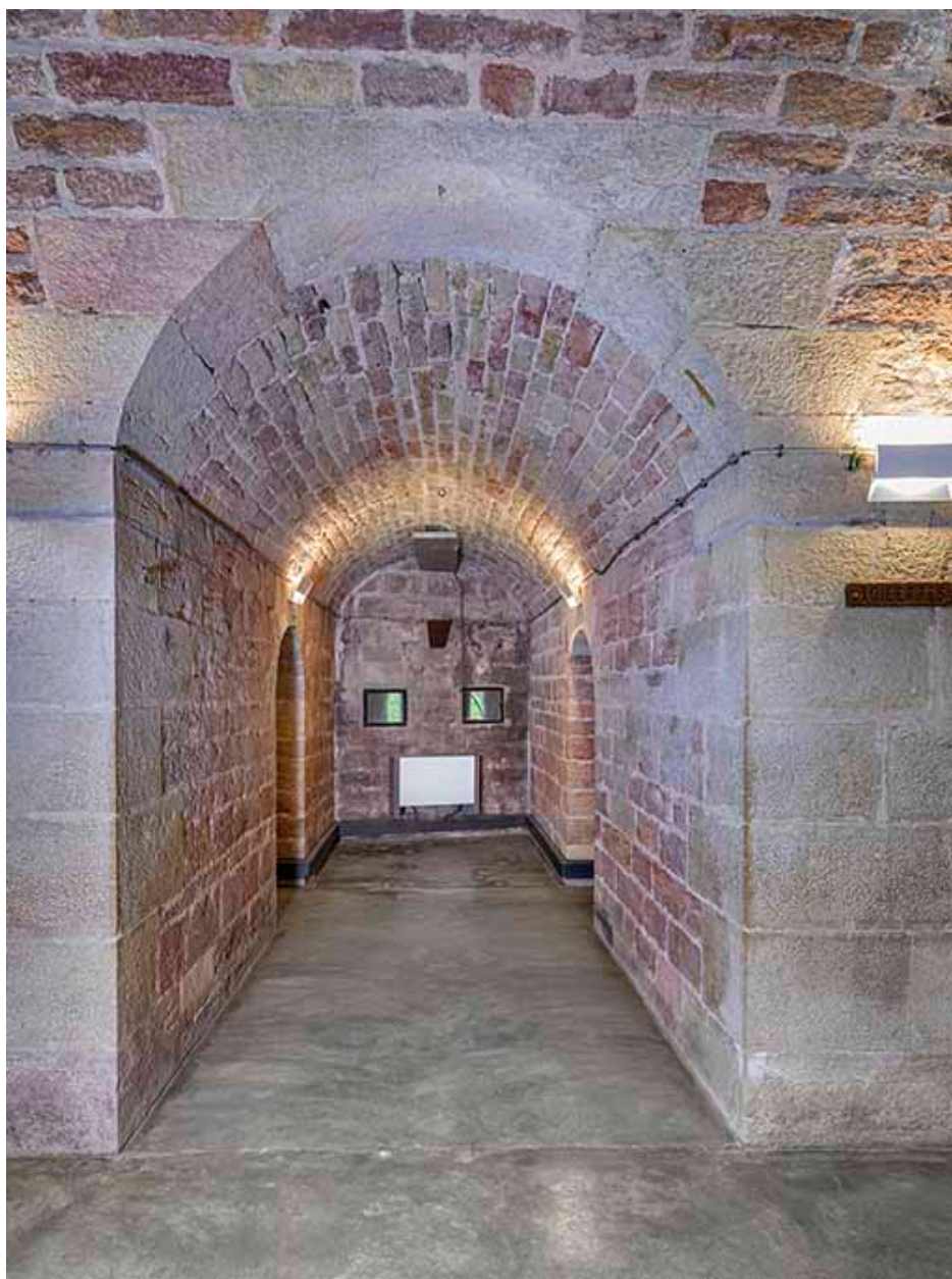
Tour Beauregard : galerie voûtée et embrasures, rez-de-chaussée.
