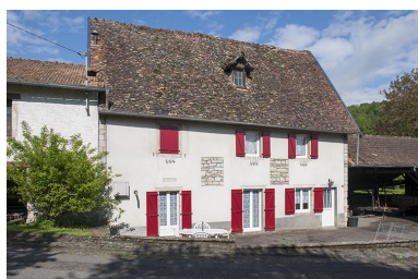
Façade est du moulin. Phot. Jérôme Mongreville IVR43_20132500411NUC4A
