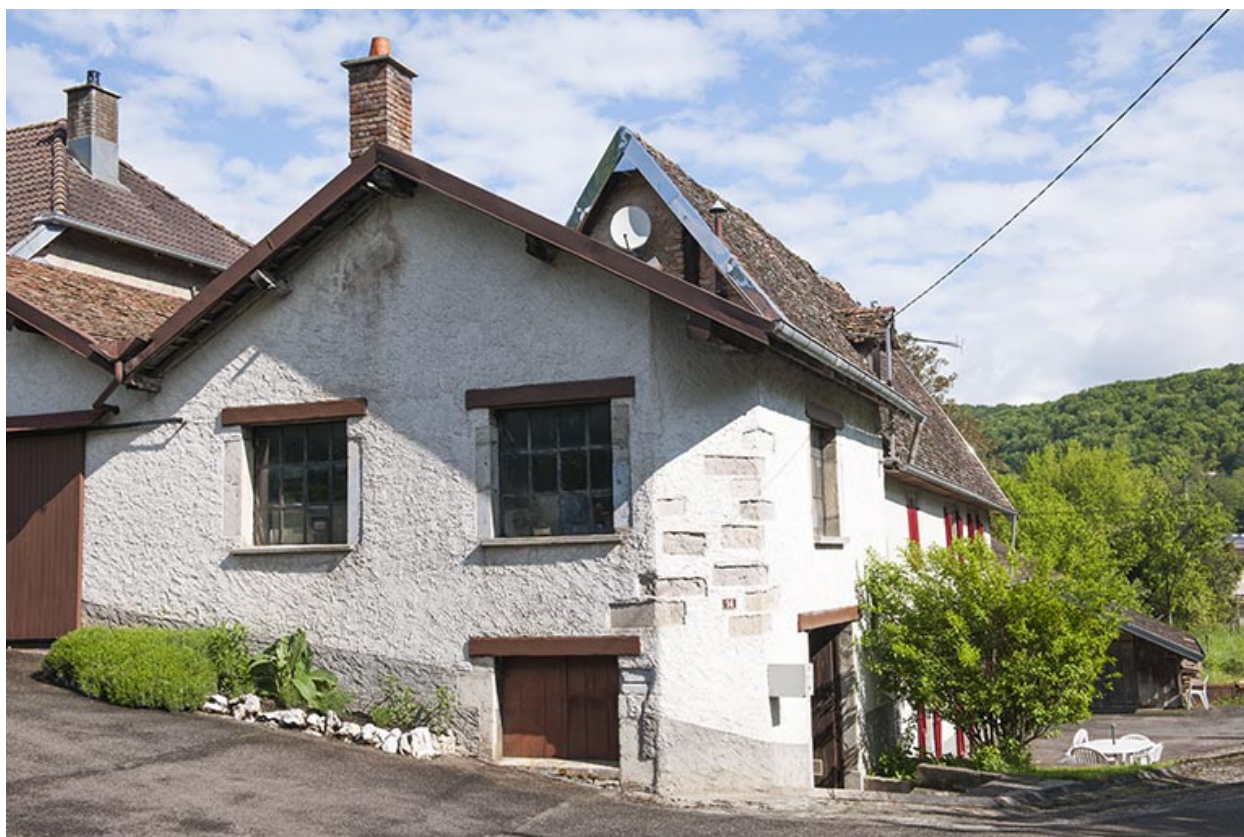
Partie est de la scierie : atelier d'affûtage.
