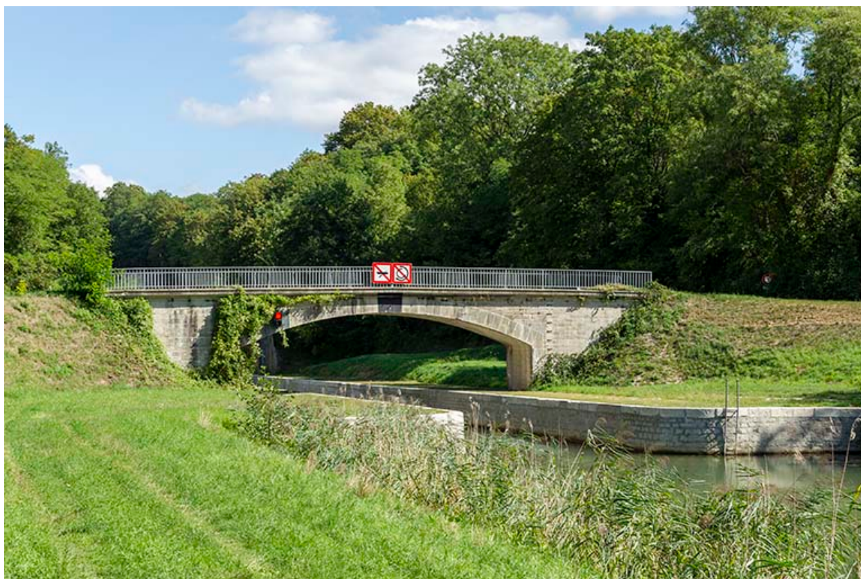
Pont routier en aval du tunnel.
