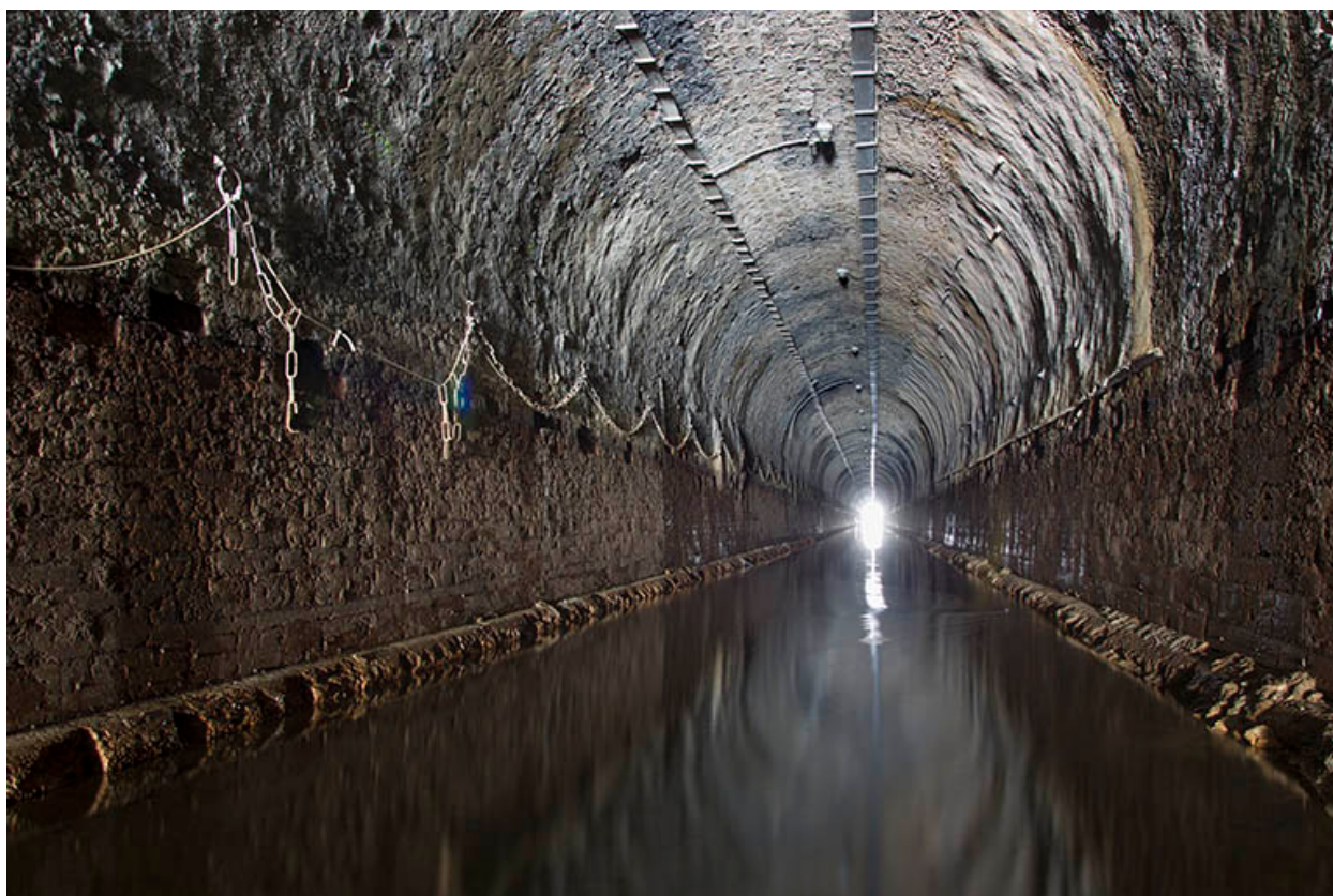
Intérieur du tunnel, vue générale.
