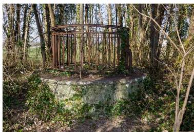
Puits d'aérage du tunnel. Phot. Sonia Dourlot IVR43_20157000263NUC2A
