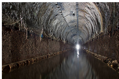
Intérieur du tunnel, vue générale. Phot. Sonia Dourlot IVR43_20157000256NUC2A
