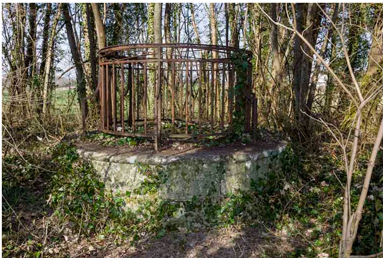
Puits d'aérage du tunnel.
