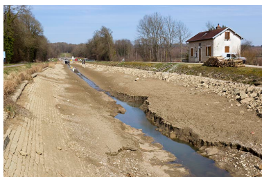
Travaux de curage du canal en 2015, partie aval de la dérivation de Savoyeux. Phot. Sonia Dourlot IVR43_20157000271NUC2A
