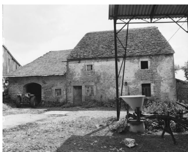
Le Fied : ferme située rue de l'Oratoire. Phot. Yves Sancey IVR43_19813900095X
