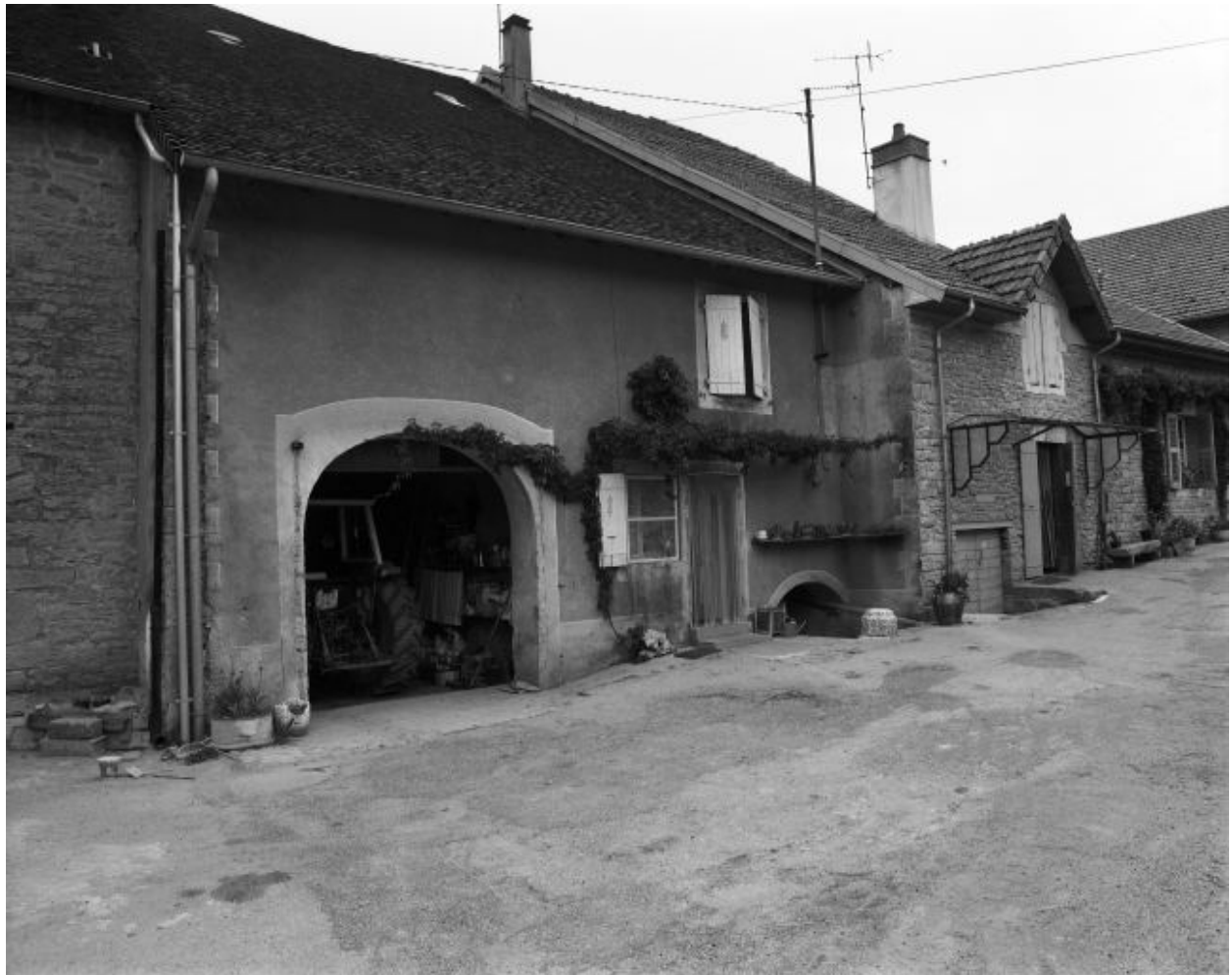
Frontenay : ferme située impasse de la Muriat.
