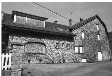
Blois-sur-Seille : maison cadastrée 1964 AB 13. Phot. F. Pernin IVR43_19743900092Z
