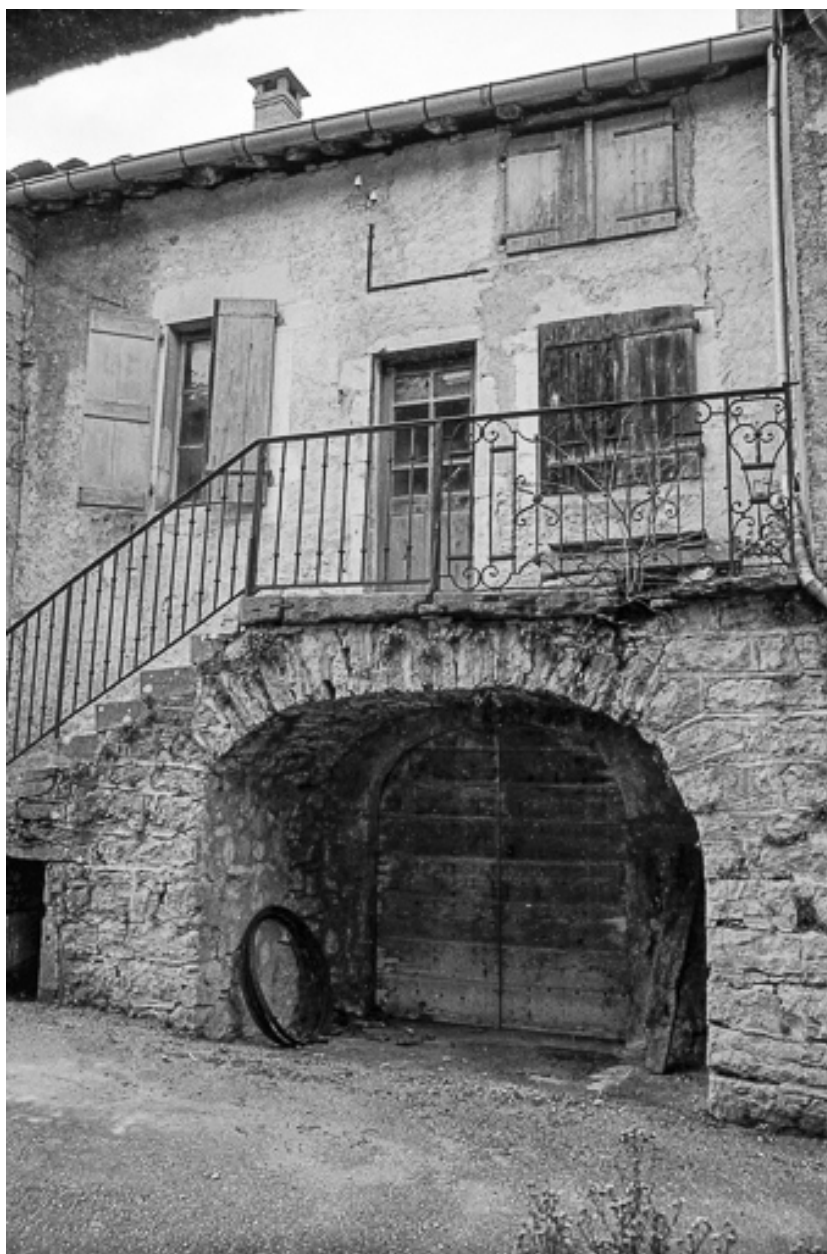
Lavigny : maison de vigneron située impasse du Quart d'Amont.
