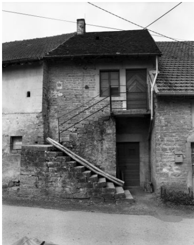
Plainoiseau : maison de vigneron située rue Saint-Antoine. Phot. Yves Sancey IVR43_19813900247X
