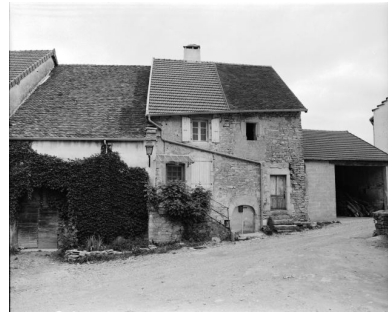
Château-Chalon : maison située rue de l'Eglise. Phot. Yves Sancey IVR43_19823900071X
