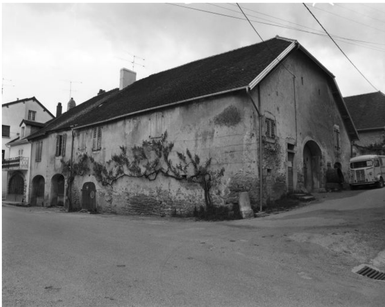
Lavigny : ferme située rue du Clos.
