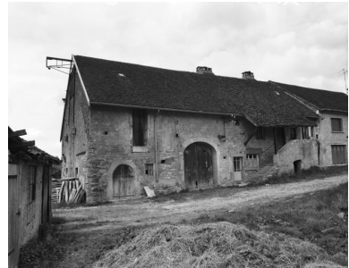
Lavigny : ferme située rue du Tour. Phot. Yves Sancey IVR43_19813900144X
