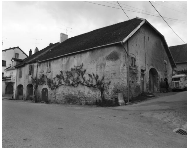
Lavigny : ferme située rue du Clos. Phot. Yves Sancey IVR43_19813900141X
