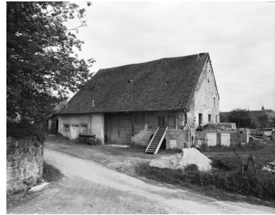
Plainoiseau : ferme située rue Alfred Labordère. Phot. Yves Sancey IVR43_19813900249X
