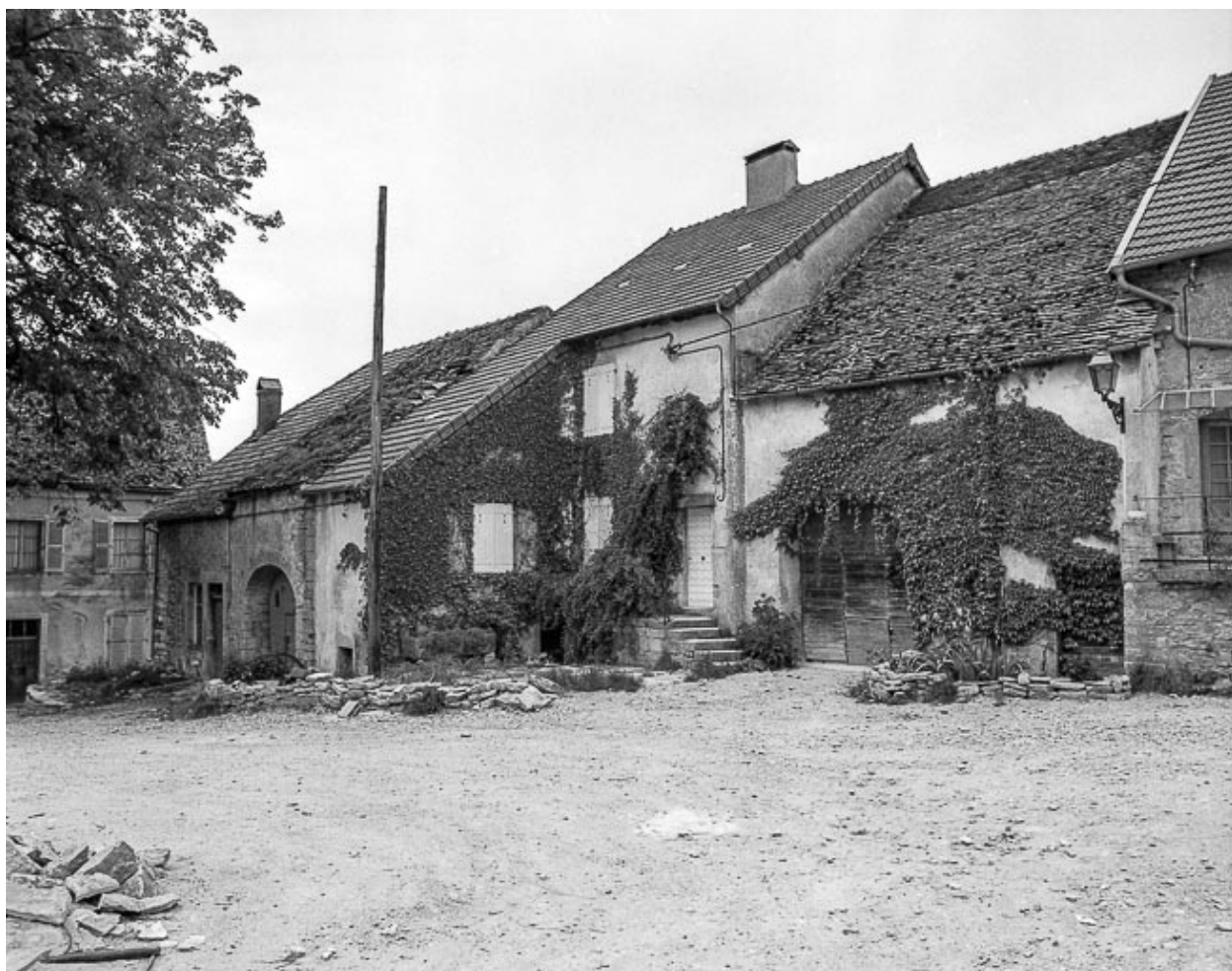
Château-Chalon : fermes situées rue de l'Eglise.
