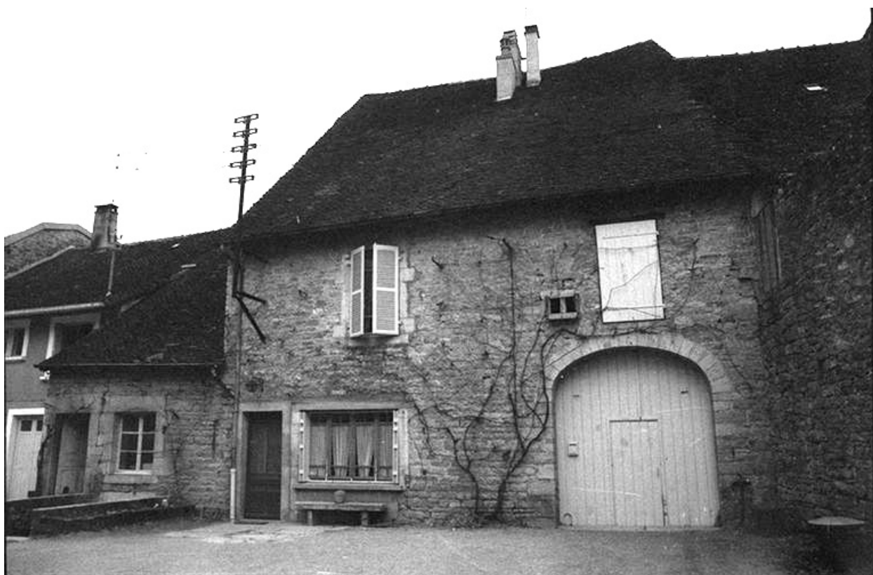
Voiteur : ferme située rue du Presbytère
