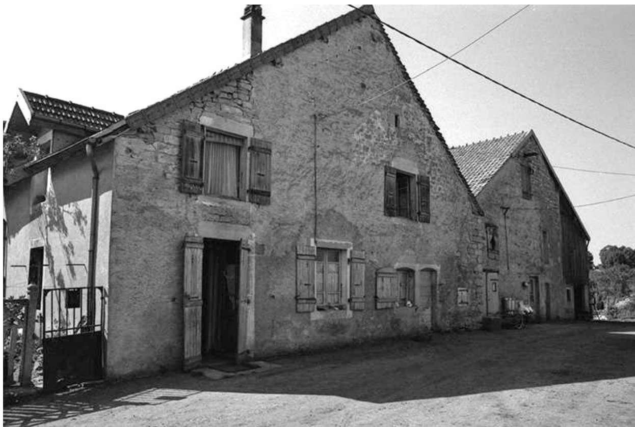
La Marre : maison située le long du chemin de grande communication n° 96 de Plasne à Mirebel.
