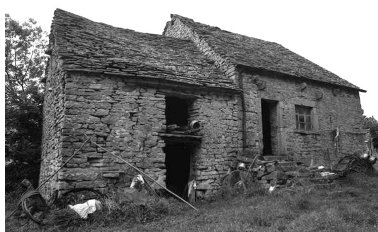
Baume-les-Messieurs : ferme située au lieudit La Peyrouse, datée de 1690. A noter le toit en lave et les murs pignon en pierre sèche. Phot. F. Pernin IVR43_19743900262Z
