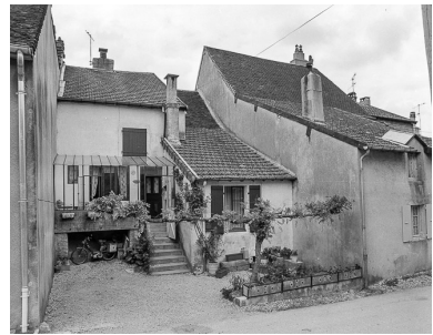
Lavigny : maison de vigneron située rue de la Forge. Phot. Yves Sancey IVR43_19813900135X
