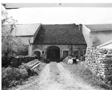
Granges-sur-Baume : ferme située route de la Chapelle. Phot. Yves Sancey IVR43_19813900122X
