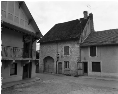
Lavigny : ferme située Grande Rue. Phot. Yves Sancey IVR43_19813900143X
