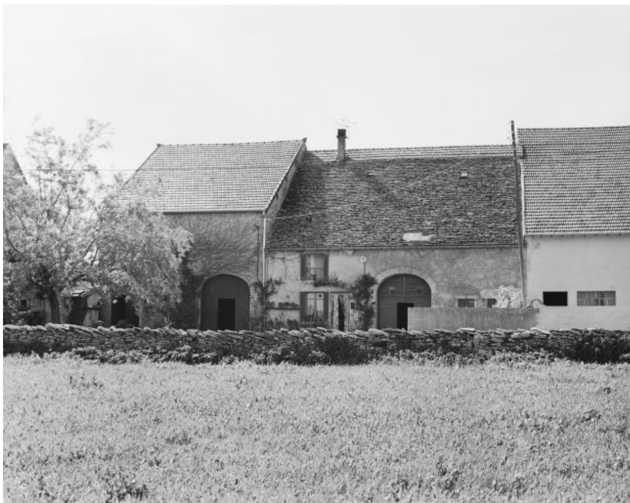
Granges-sur-Baume : ferme située route de la Mille.
