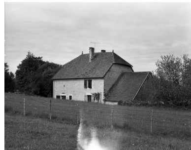
Saint-Germain-lès-Arlay : ferme située chemin de la Muyre. Phot. Yves Sancey IVR43_19813900257X
