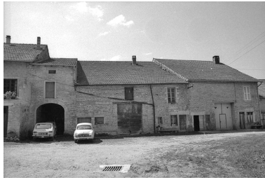
Granges-sur-Baume : fermes situées le long du chemin départemental n° 210 de Crançot à La Marre. Phot. F. Pernin IVR43_19743900190Z
