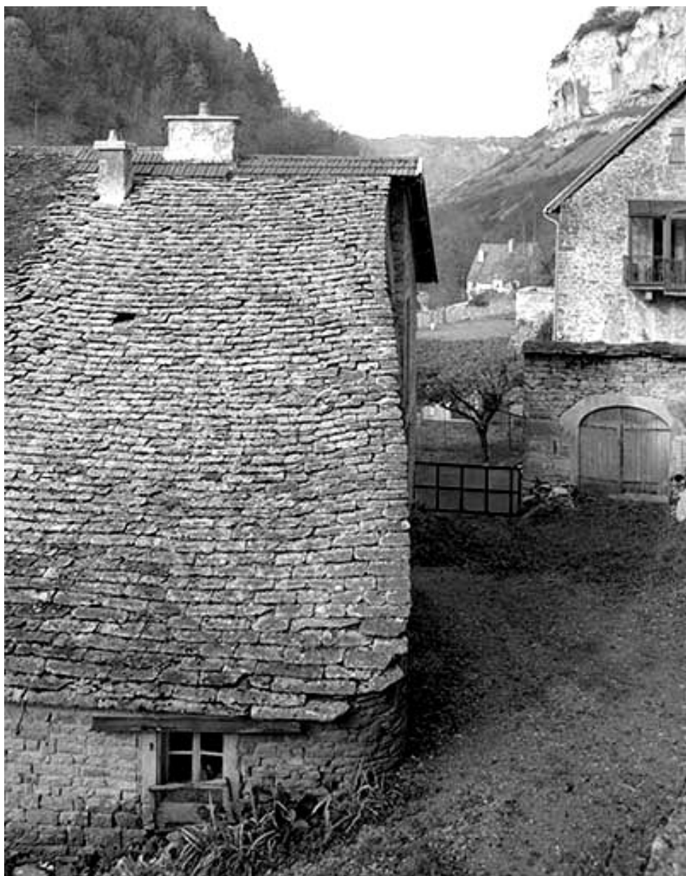
Baume-les-Messieurs : détail d'une toiture en laves.
