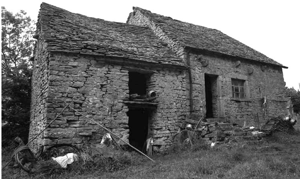
Baume-les-Messieurs : ferme située au lieudit La Peyrouse, datée de 1690. A noter le toit en lave et les murs pignon en pierre sèche.
