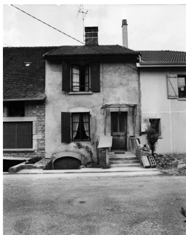
Voiteur : maison de vigneron située rue Roche. Phot. Yves Sancey IVR43_19813900266X
