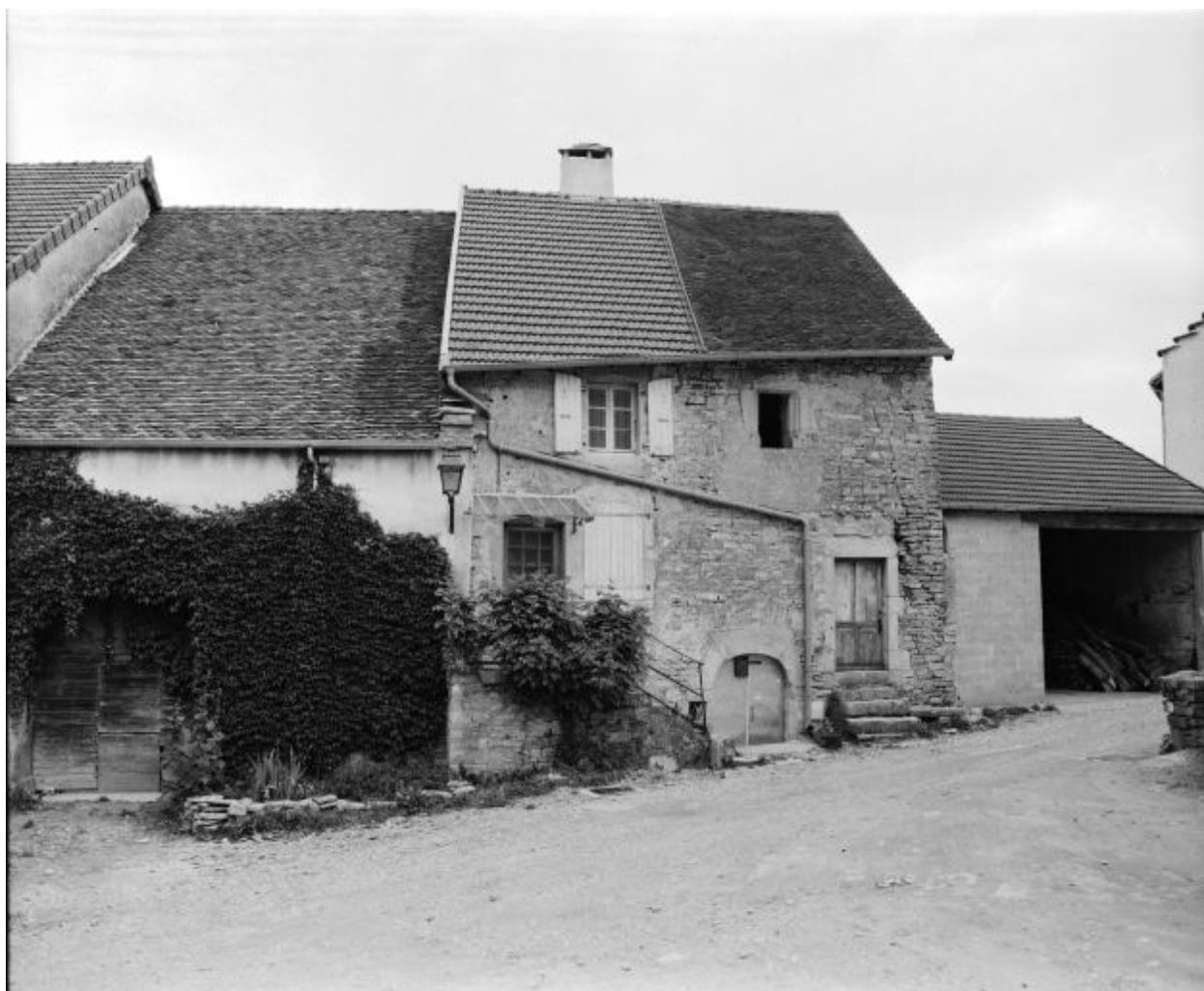
Château-Chalon : maison située rue de l'Eglise.
