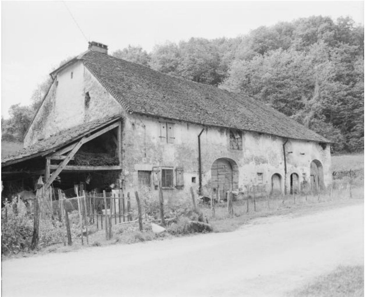
Frontenay : ferme située rue Saint-Vincent.
