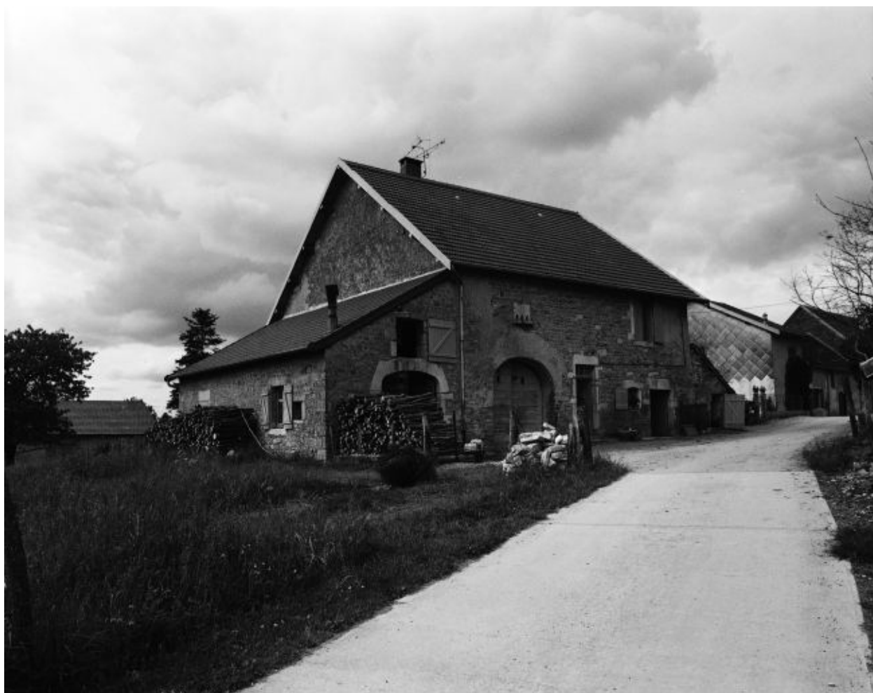
Le Vernois : ferme située rue de la Mare.
