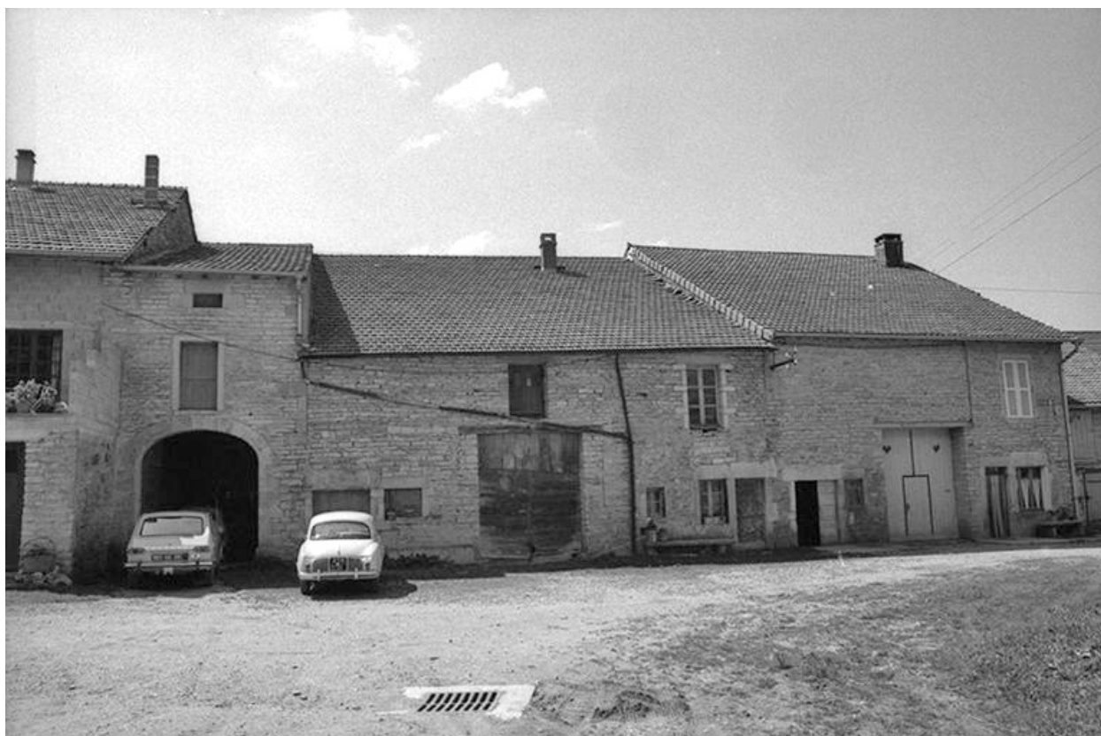
Granges-sur-Baume : fermes situées le long du chemin départemental n° 210 de Crançot à La Marre.
