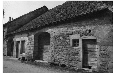
Blois-sur-Seille : ferme cadastrée 1964 AB 52 et 53. A noter le toit en lave. Phot. F. Pernin IVR43_19743900113Z
