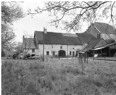
Saint-Germain-lès-Arlay : ferme située chemin de la Butte (?). Phot. Yves Sancey IVR43_19813900258X
