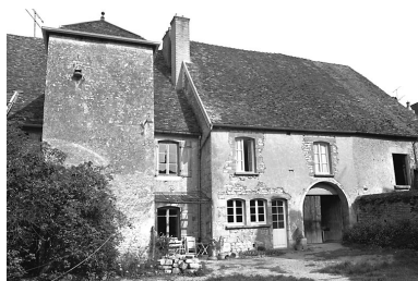
Façade sur cour Phot. Dominique Dominguez IVR43_19807000529X
