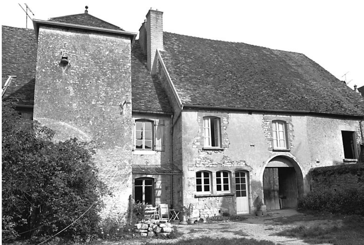
Façade sur cour
