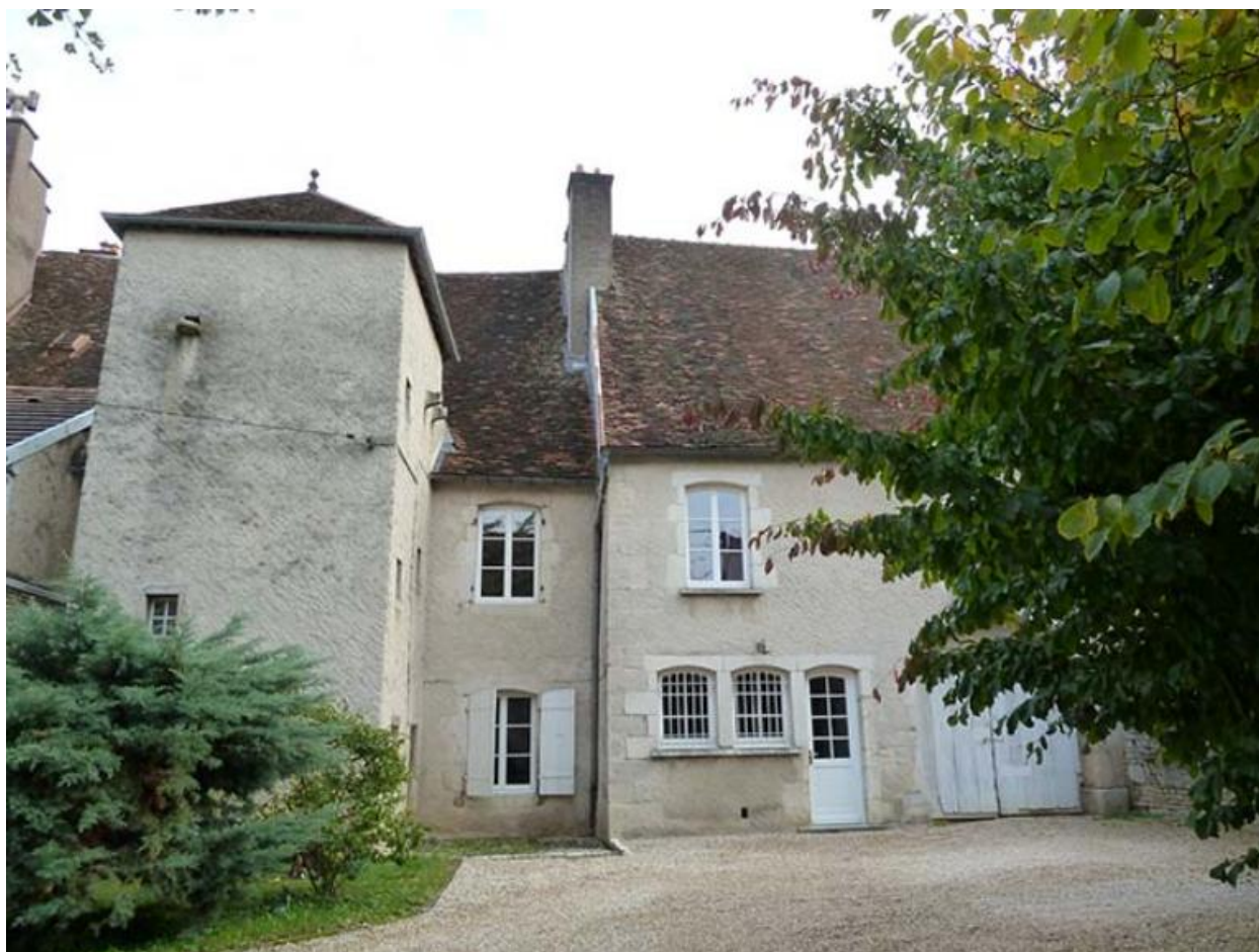
Vue générale ouest
