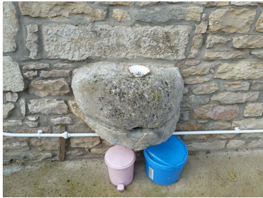
"Goulotte" d'évacuation de l'évier intérieur Phot. Sabrina Dalibard IVR43_20137000854NUC2A
