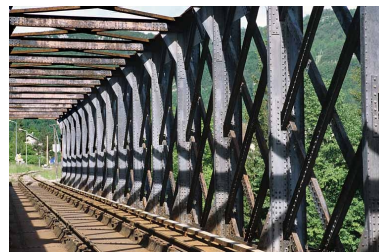
Paroi aval, depuis le tablier côté Andelot-en-Montagne.
