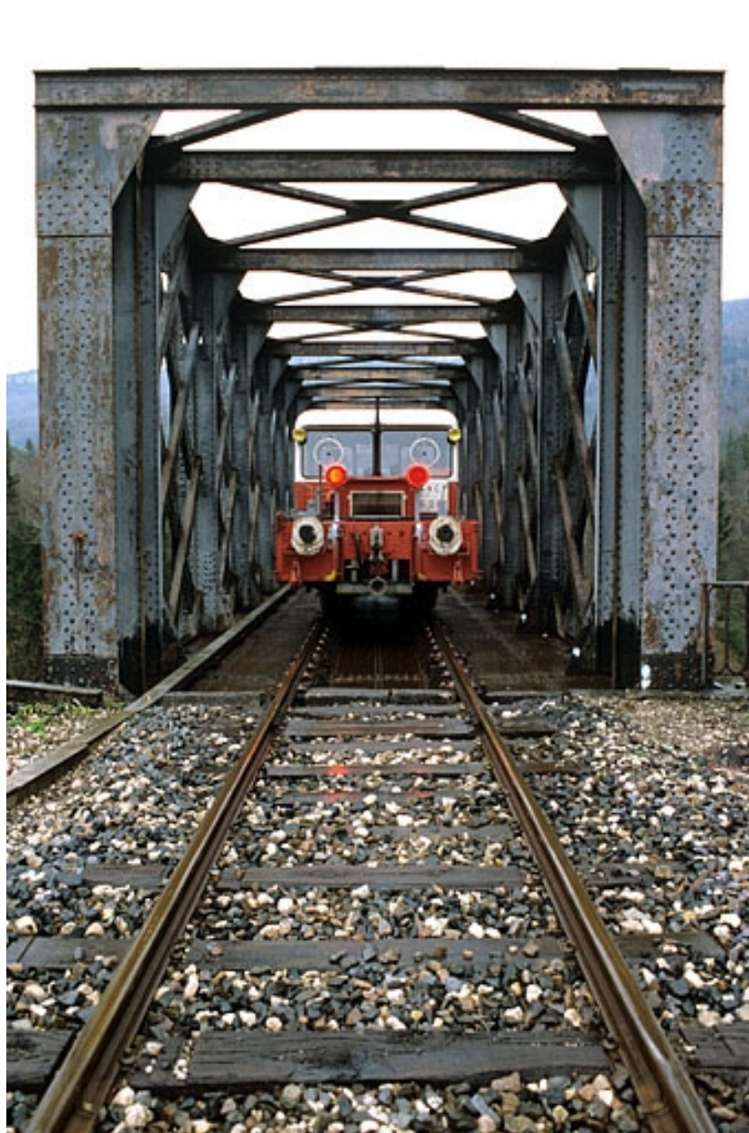
Extrémité côté La Cluse, avec draisine.
