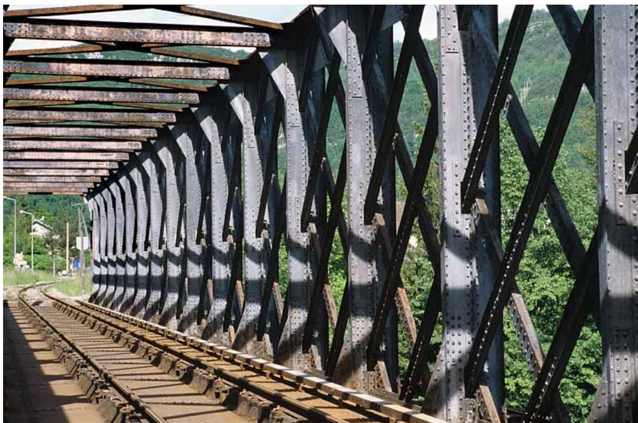
Paroi aval, depuis le tablier côté Andelot-en-Montagne.
