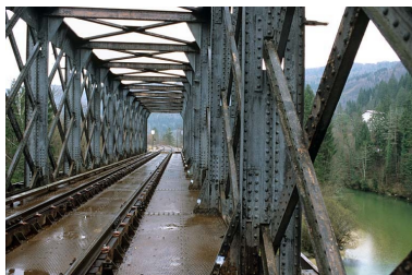
Charpente métallique, tablier et voie.
