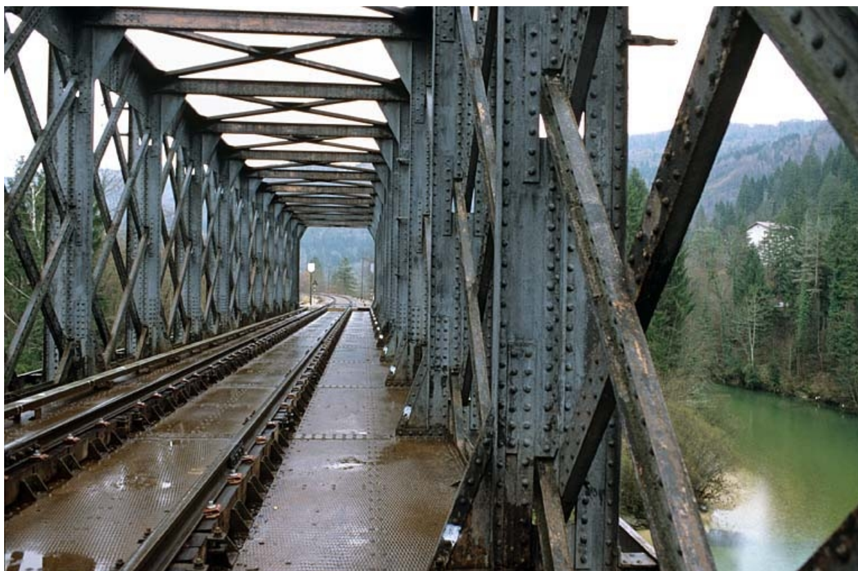
Charpente métallique, tablier et voie.
