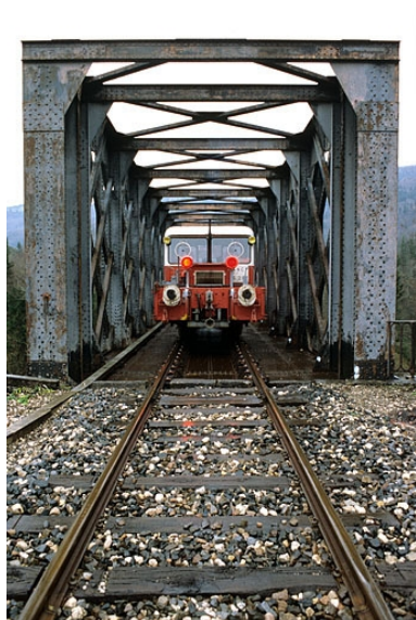
Extrémité côté La Cluse, avec draine.
