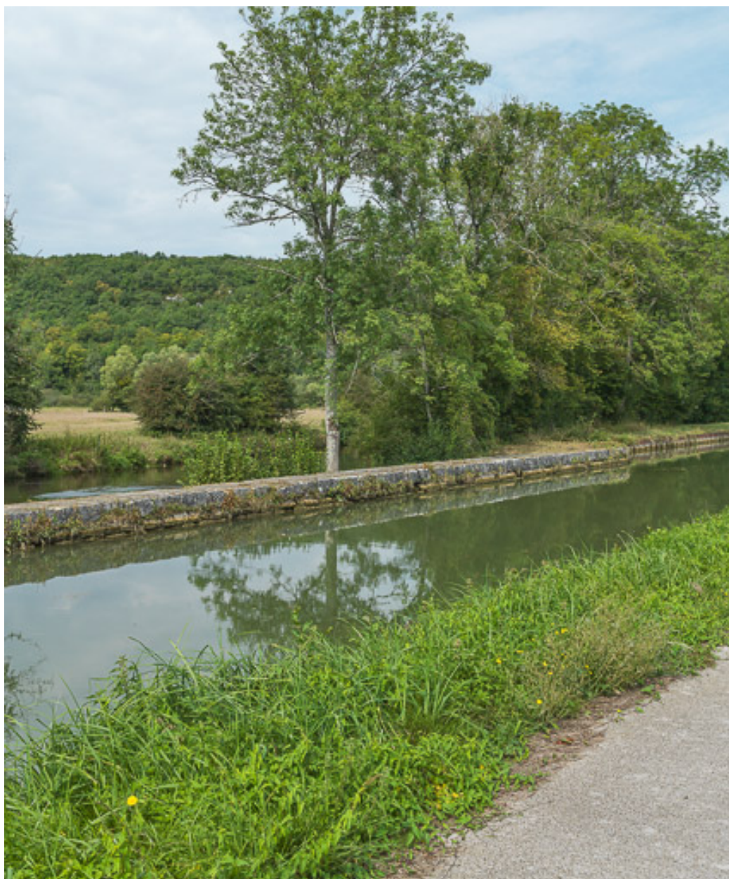
Détail de la digue.
