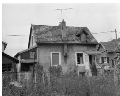
Maison individuelle 5 rue du Cercle en 1981. Phot. Yves Sancey IVR43_19812500429X
