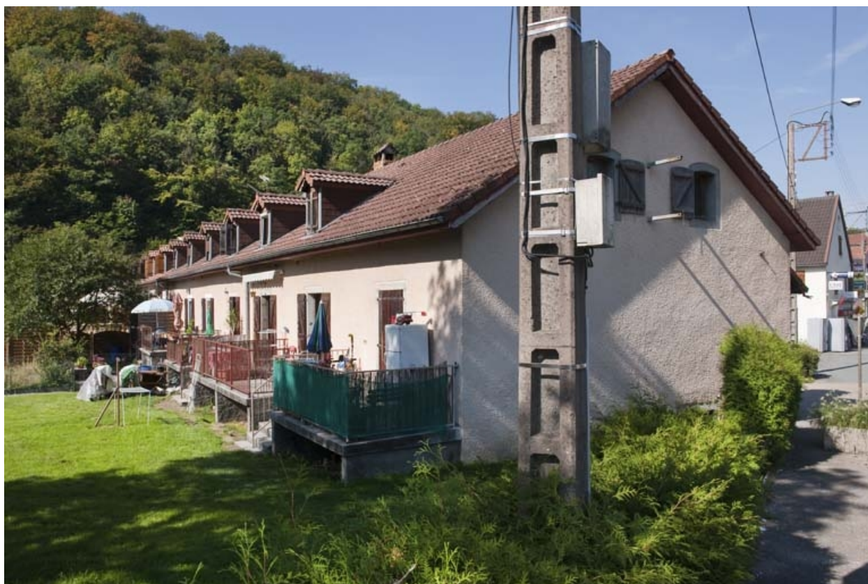
Caserne G. Façade postérieure vue depuis l'est.
