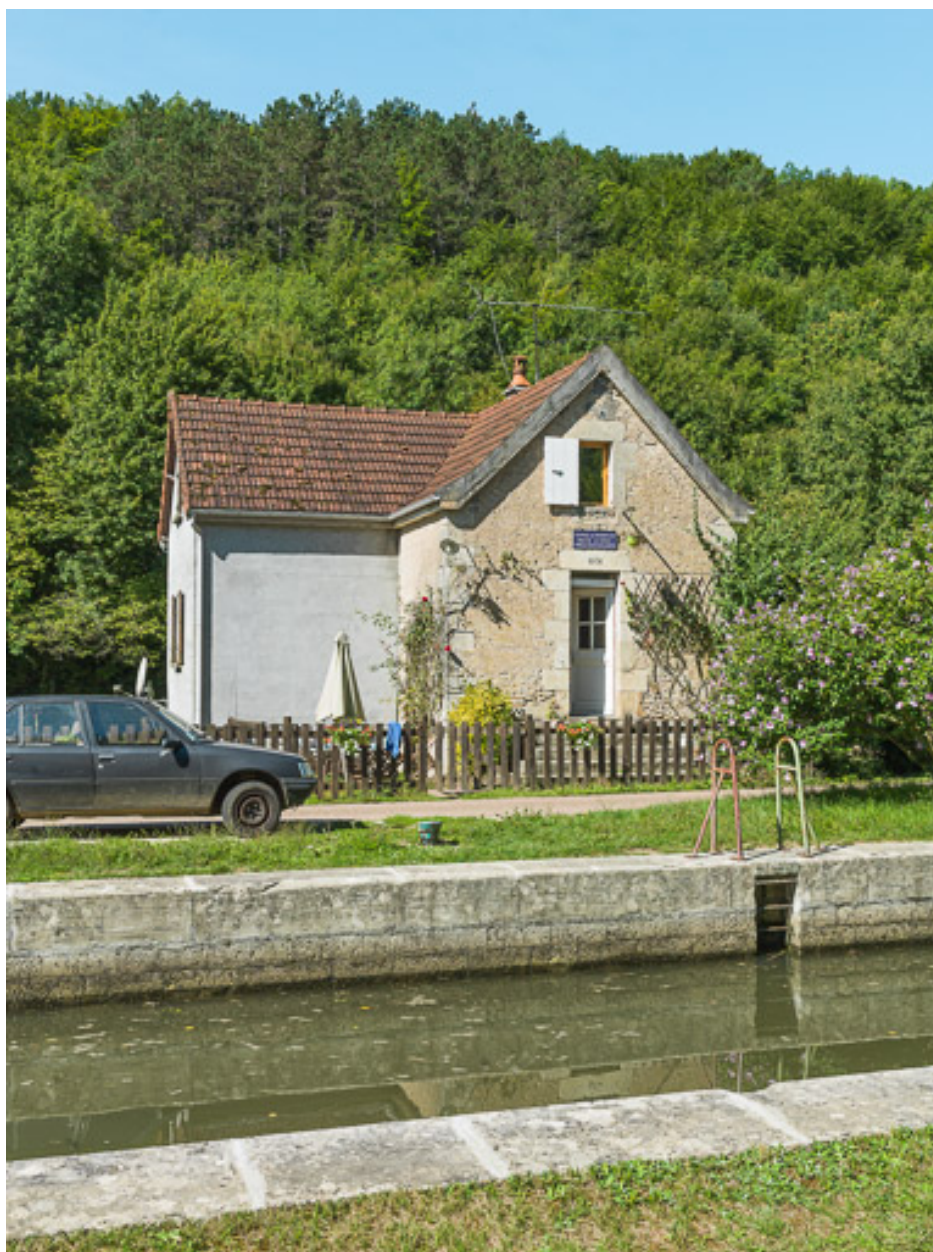
Vue de la maison éclusière.
