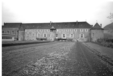
Façade sud-ouest. Phot. Guy Forestier IVR43_19743900325Z
