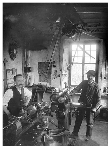
[L'atelier de mécanique, avec au premier plan Adelin Berçot et au second plan un ouvrier], vers 1913. Phot. Yves Sancey, Autr. auteur inconnu IVR43_20132501952NUC2A
