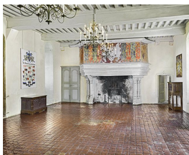
Vue d'ensemble de la cheminée. Phot. Thierry Kuntz IVR26_20152100090NUC4A
