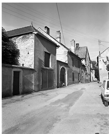
Maison de vigneron située 3 rue Saint-Claude. Phot. Yves Sancey IVR43_19802501370X
