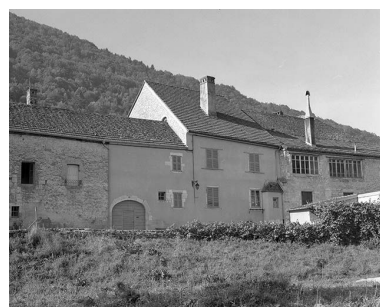
Maisons situées rue Gérard. Phot. Yves Sancey IVR43_19802501350X
