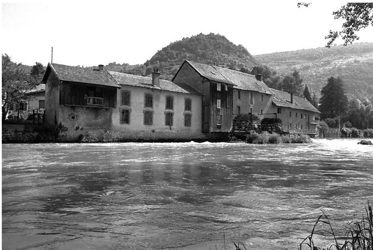
Moulin situé route de Pontarlier.
