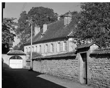
Demeure située 5 chemin de Vervaux. Phot. Yves Sancey IVR43_19802501373X
