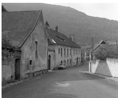
Demeure, actuellement maison de retraite dite la Résidence, située rue Jean-Pierre Bangue. Phot. Yves Sancey IVR43_19802501391X
