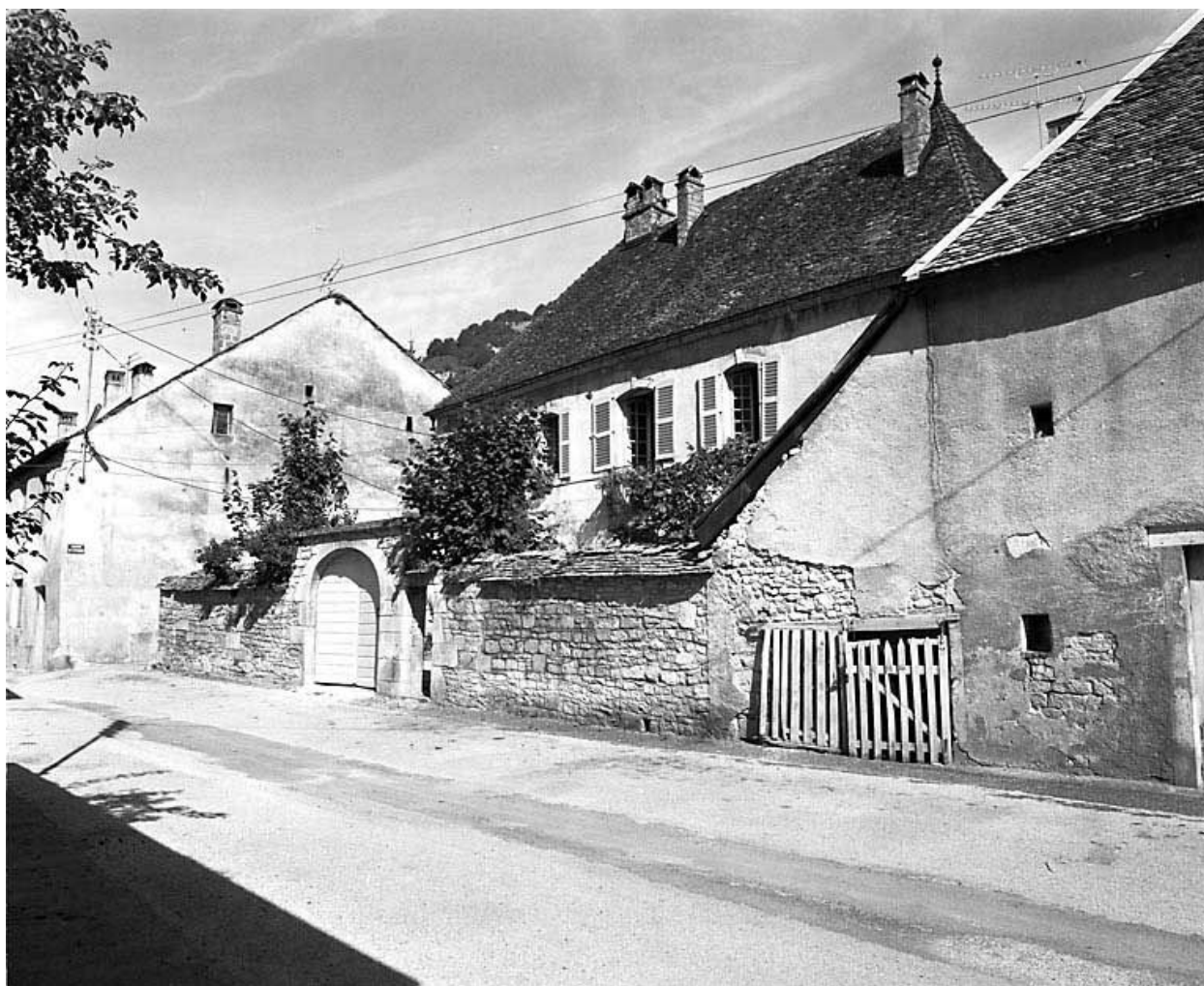
Maison de vigneron située 8 rue Carnot.
