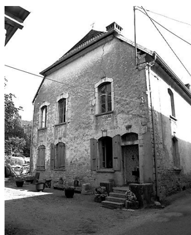
Maison située 16 rue Carnot. Phot. Yves Sancey IVR43_19802501368X
