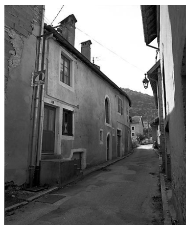
Maison de vigneron située 9 rue Saint Claude. Phot. Yves Sancey IVR43_19802501359X
