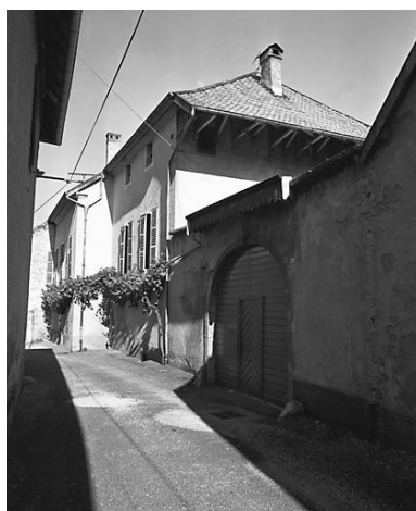
Maison située 2 rue Téméraire. Phot. Yves Sancey IVR43_19802501377X
