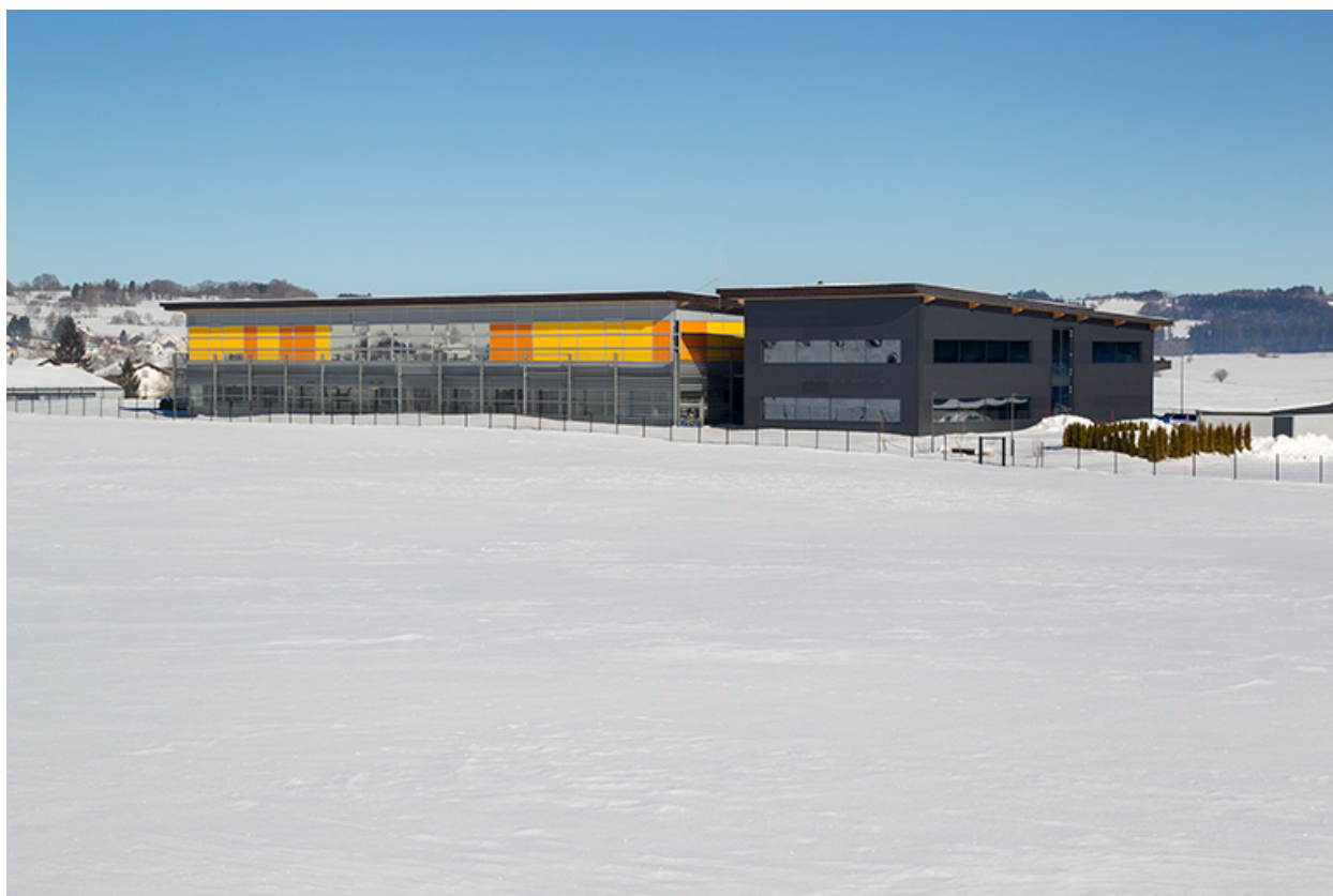
Façades postérieure et latérale gauche, en hiver.
