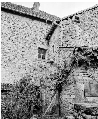
Façade postérieure. Phot. Yves Sancey IVR43_19777000175X
