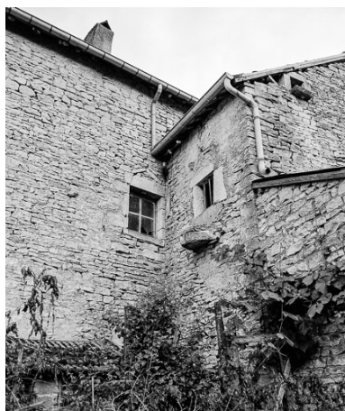
Façade postérieure. Phot. Yves Sancey IVR43_19777000174X
