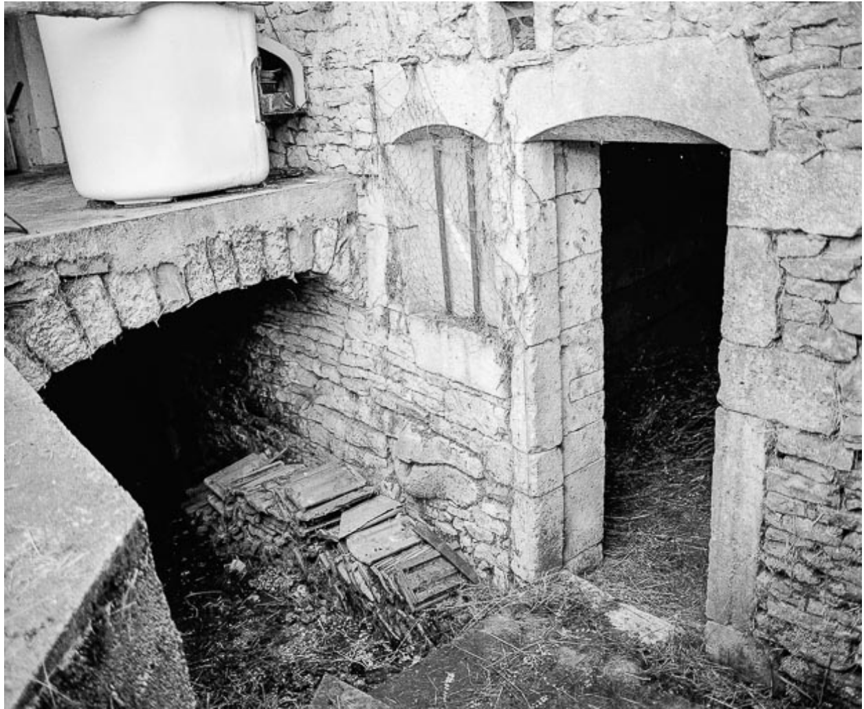
Accès aux caves.
