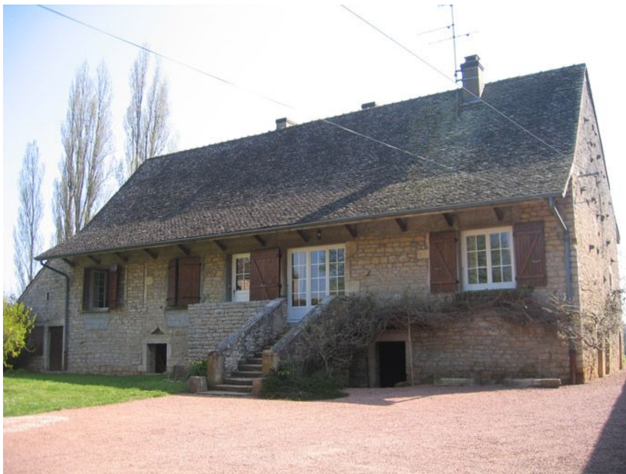
Vue d'ensemble de la façade.
