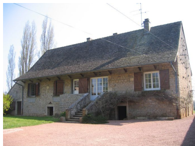
Vue d'ensemble de la façade.
