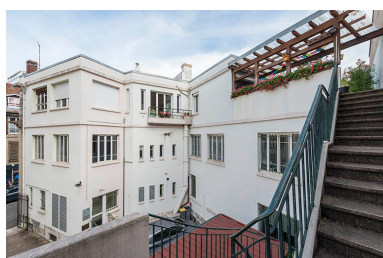
Cour intérieure. Phot. Jérôme Mongreville IVR43_20172501103NUC4A
