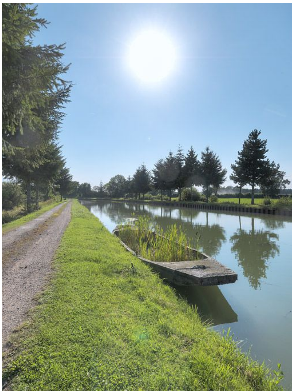
Brise-glace dans le bief 17. Alignement de sapins.
