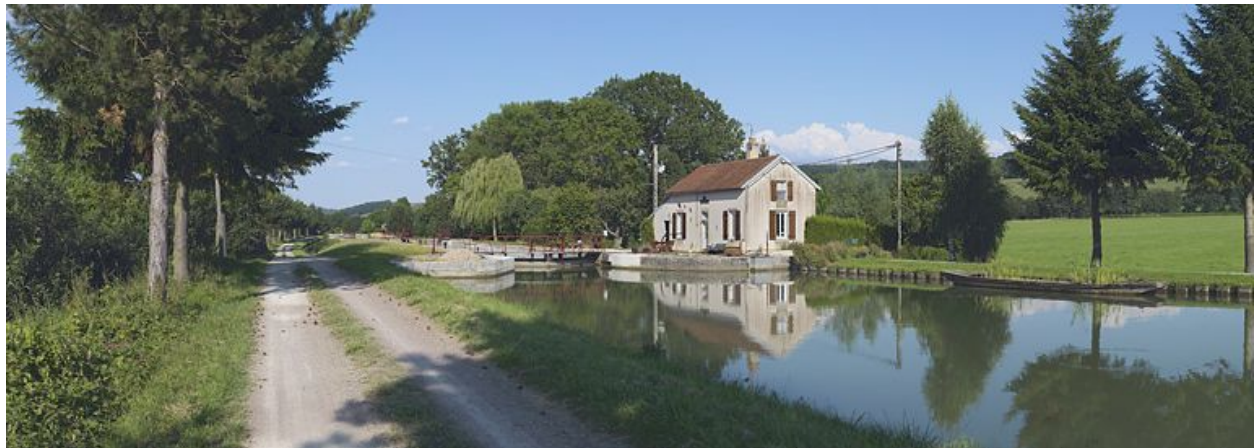
Le site d'écluse vu d'amont.
