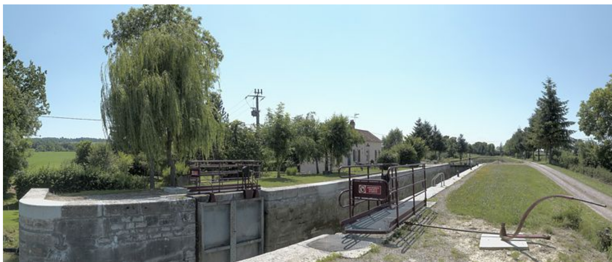
Le site d'écluse vu d'aval.
