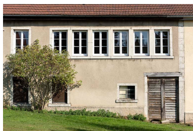
Façade postérieure : fenêtres multiples. Phot. Sonia Dourlot
