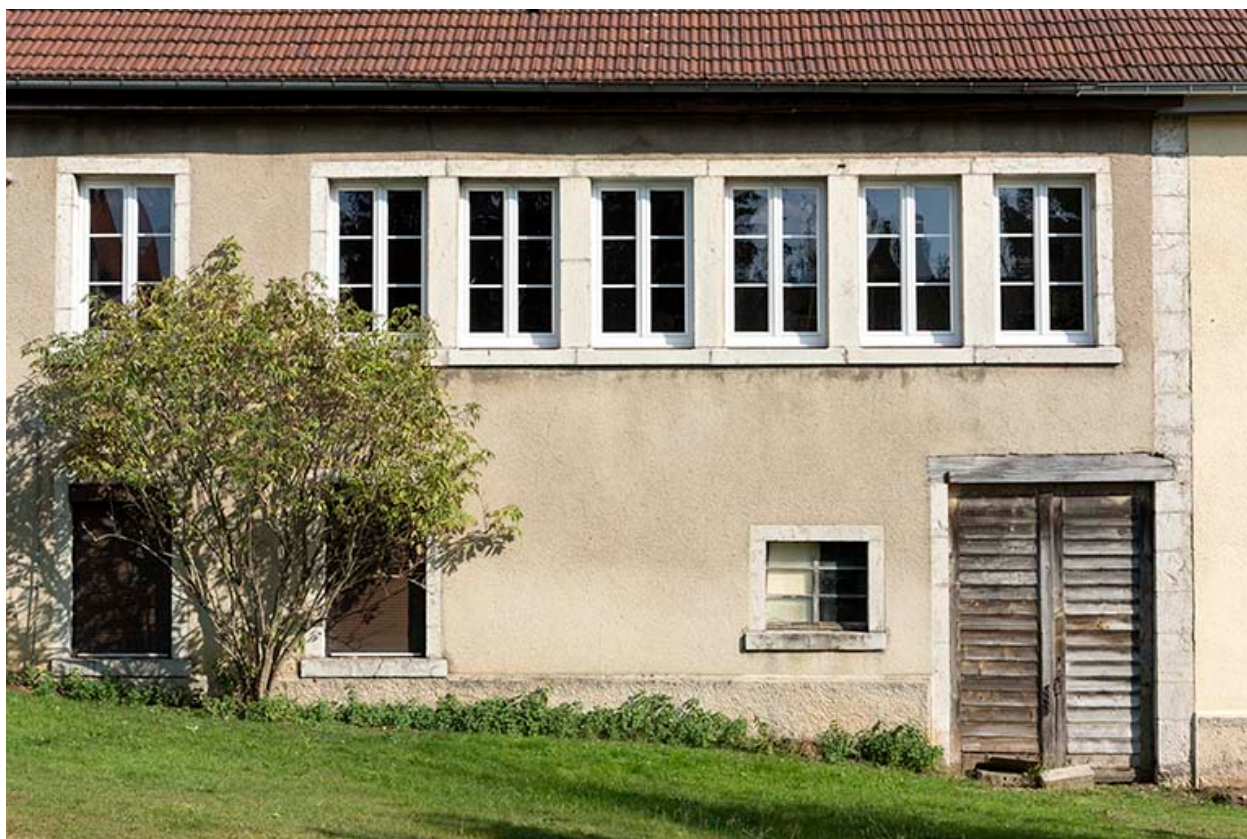
Façade postérieure : fenêtres multiples.
