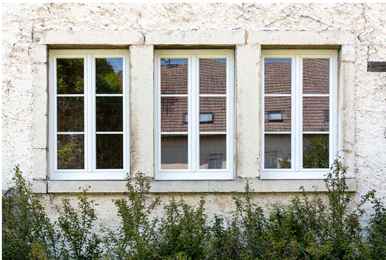
Façade latérale droite : fenêtres multiples.
