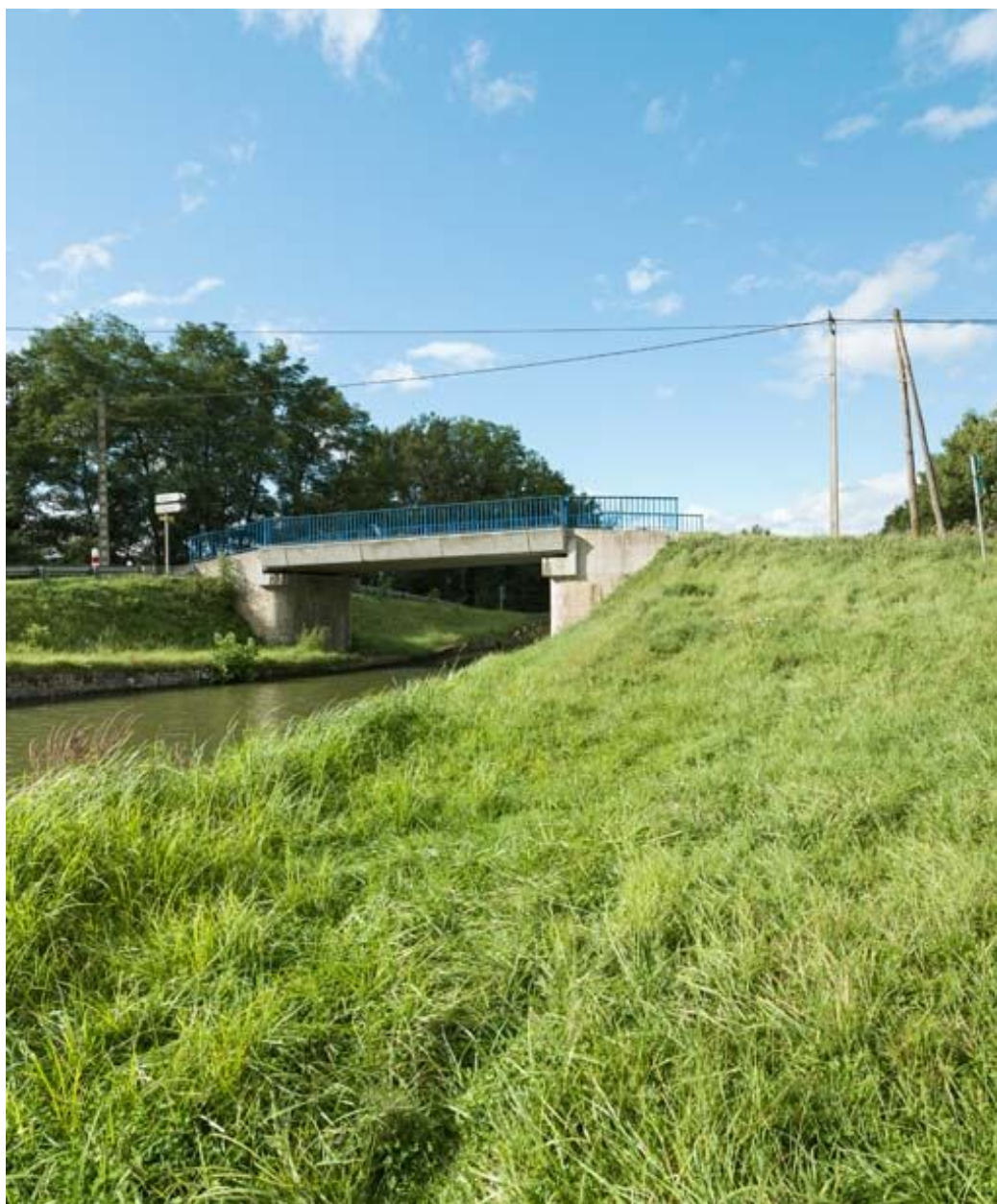
Vue d'ensemble du pont.
