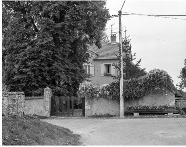
Vue d'ensemble depuis la rue. Phot. Dominique Dominguez IVR43_19807000588X
