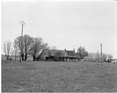
Vue générale. Phot. Bernard Lardière IVR43_19793900318X
