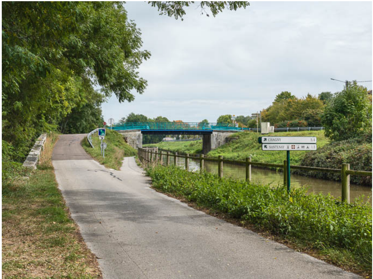
Vue d'ensemble du pont.
