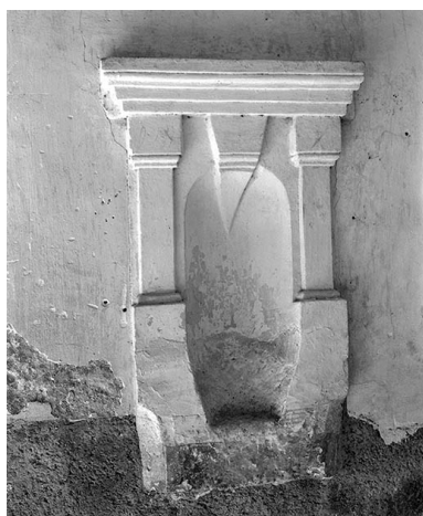
Niche avec décor d'architecture. Phot. Jean-Luc Duthu IVR26_19748900196X
