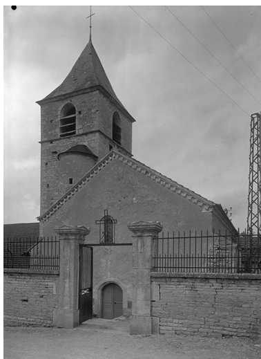
Façade occidentale avec clocher. Phot. Jean-Luc Duthu IVR26_19748900189V
