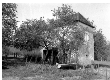
Logement de domestique. Phot. Bernard Lardière IVR43_19817000578Z
