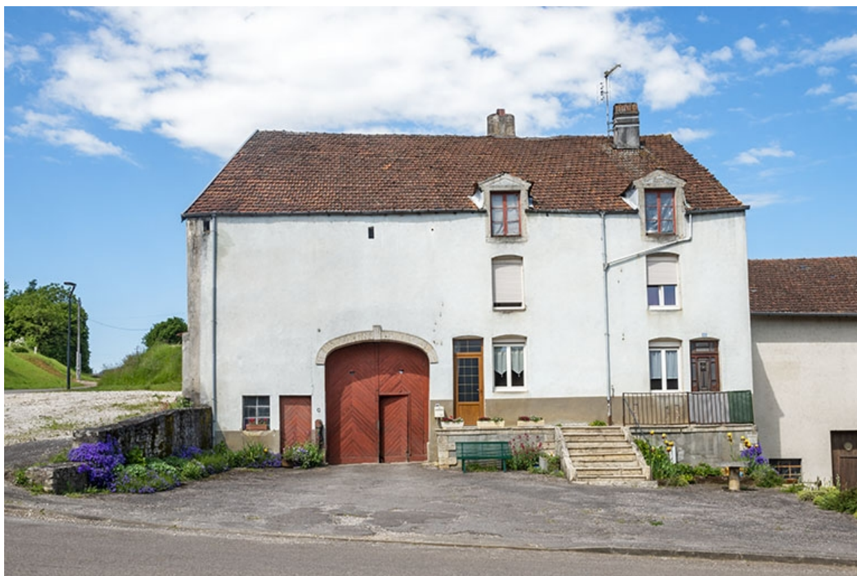
La façade antérieure depuis la rue.
