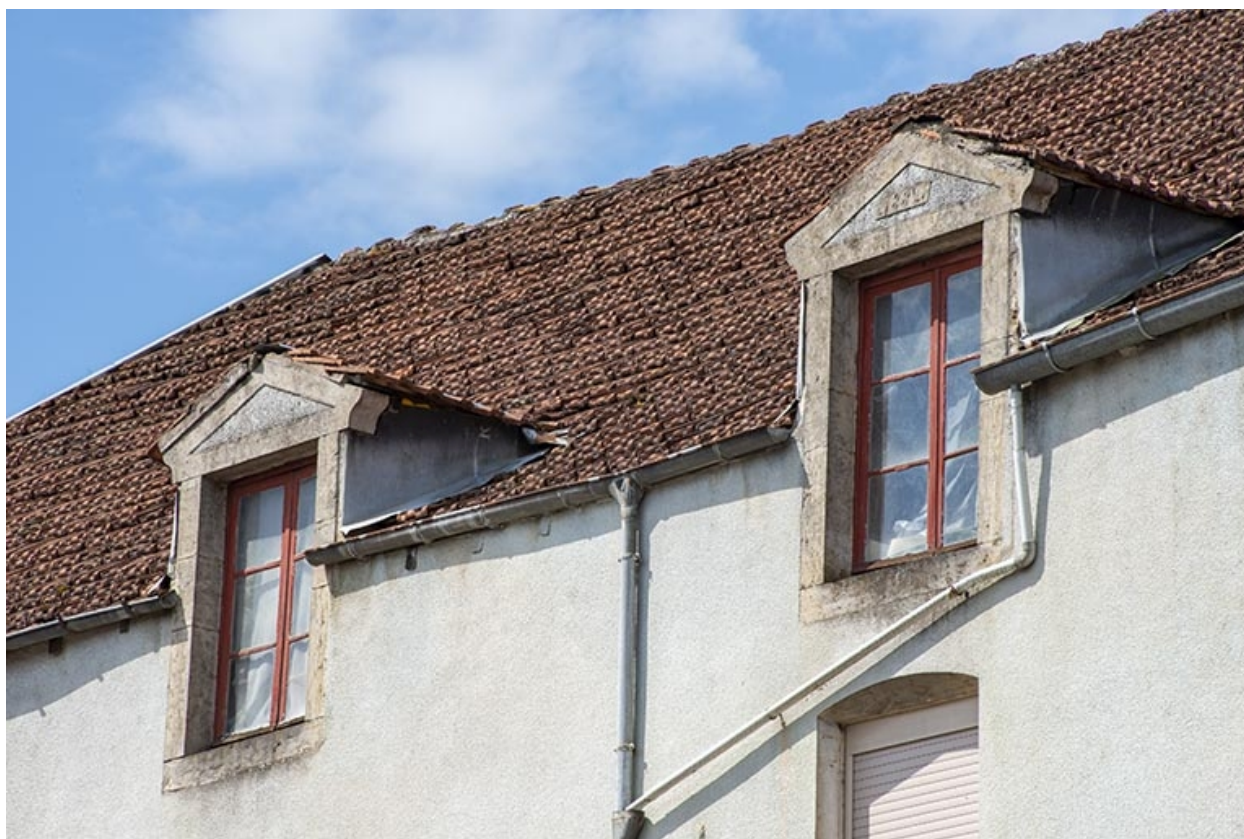
Les deux lucarnes du surcroît.
