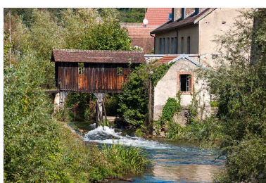
Vestiges du barrage depuis l'aval. Phot. Jérôme Mongreville IVR43_20142501320NUC4A
