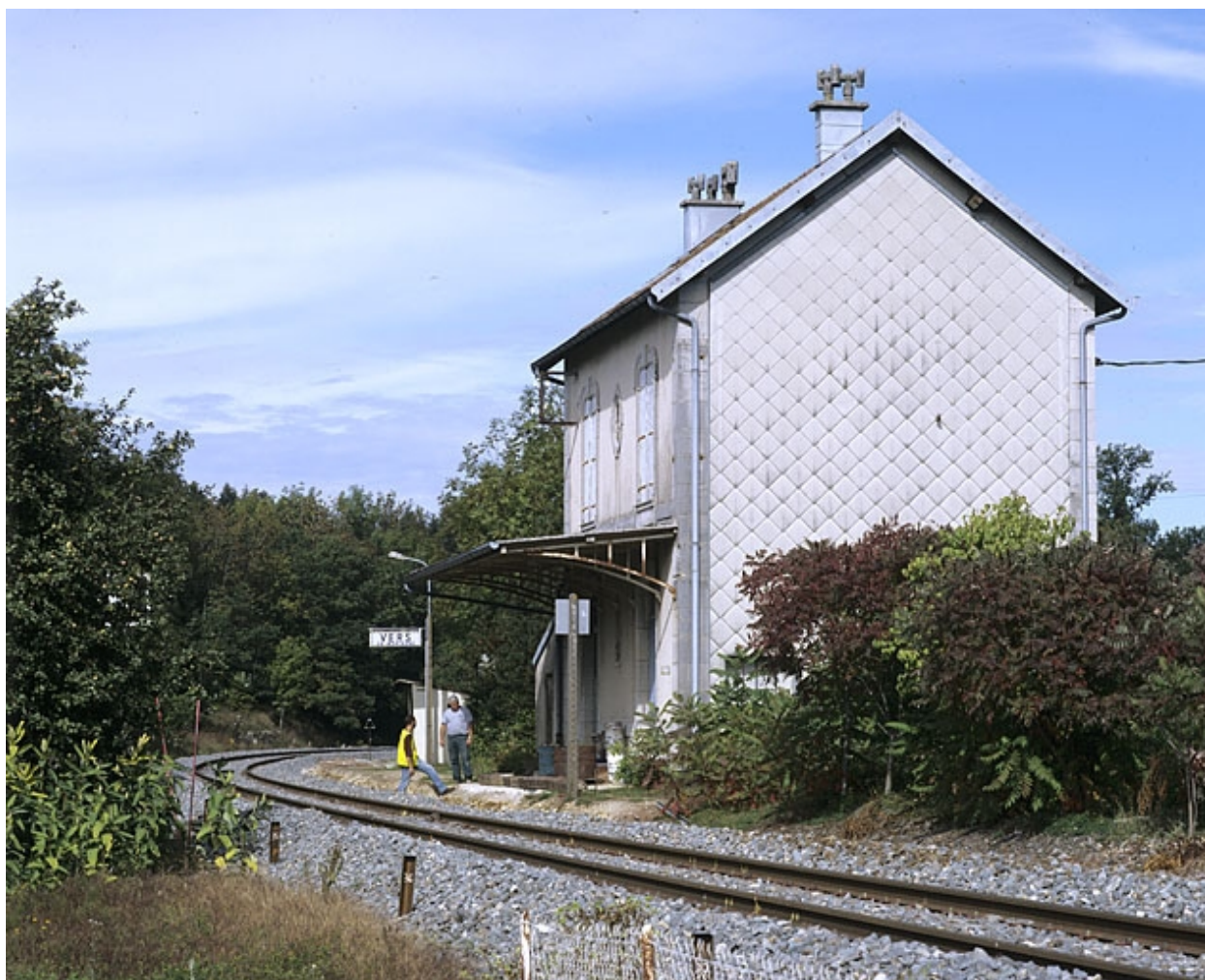
Façades postérieure et latérale gauche.
