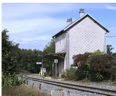
Façades postérieure et latérale gauche.
