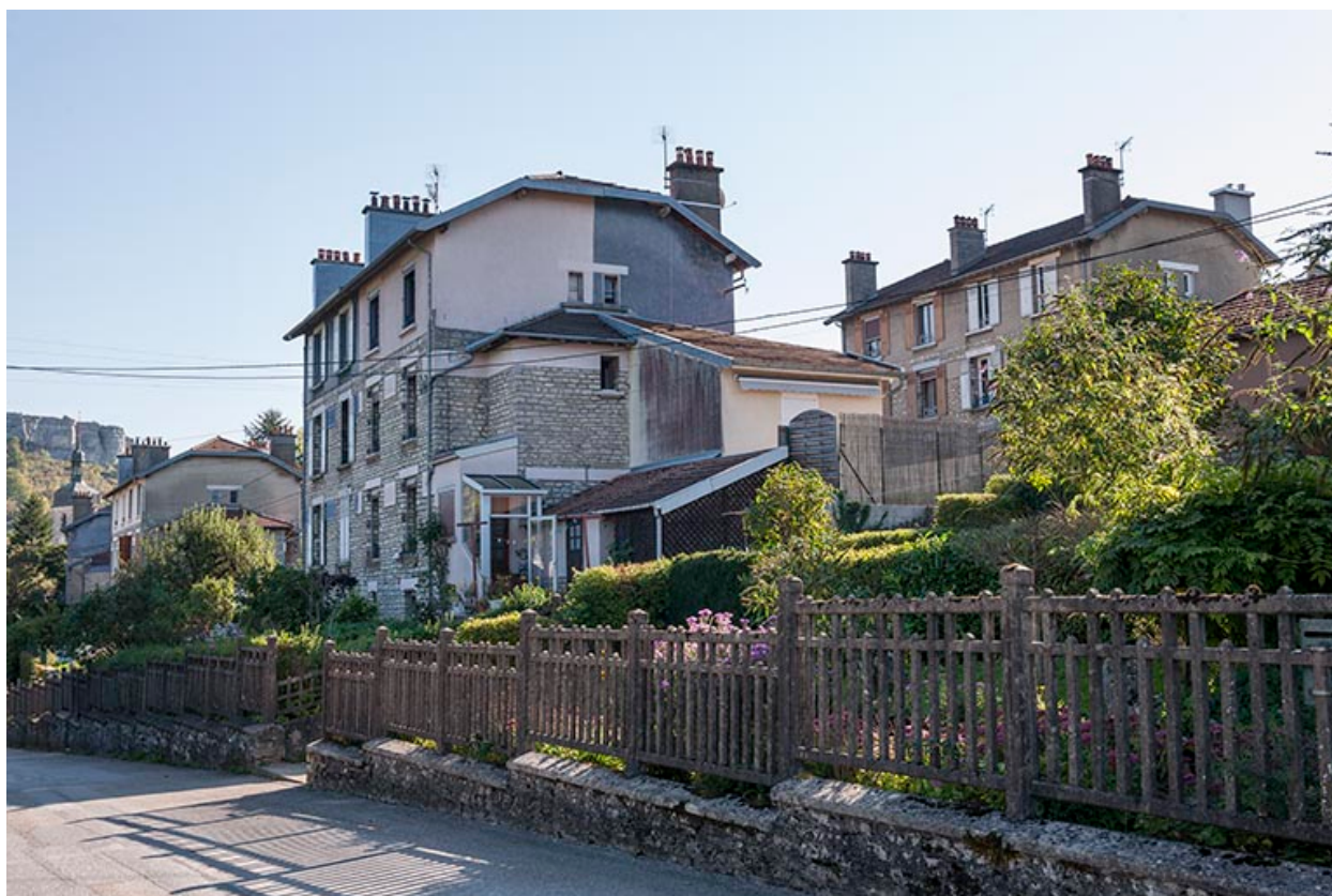
Maisons à quatre logements depuis l'avenue Tournier.
