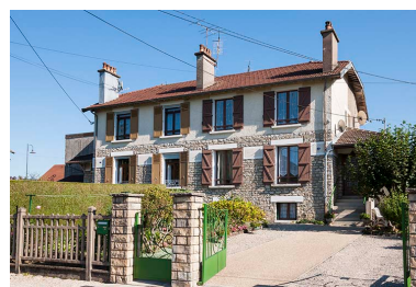
Façade antérieure d'une habitation à quatre logements. Phot. Jérôme Mongreville IVR43_20162500472NUC4A
