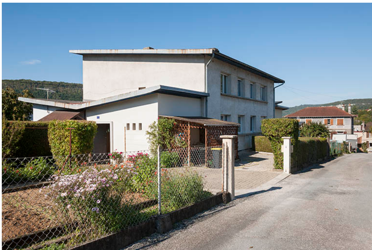
Maison à quatre logements (années 1950).
