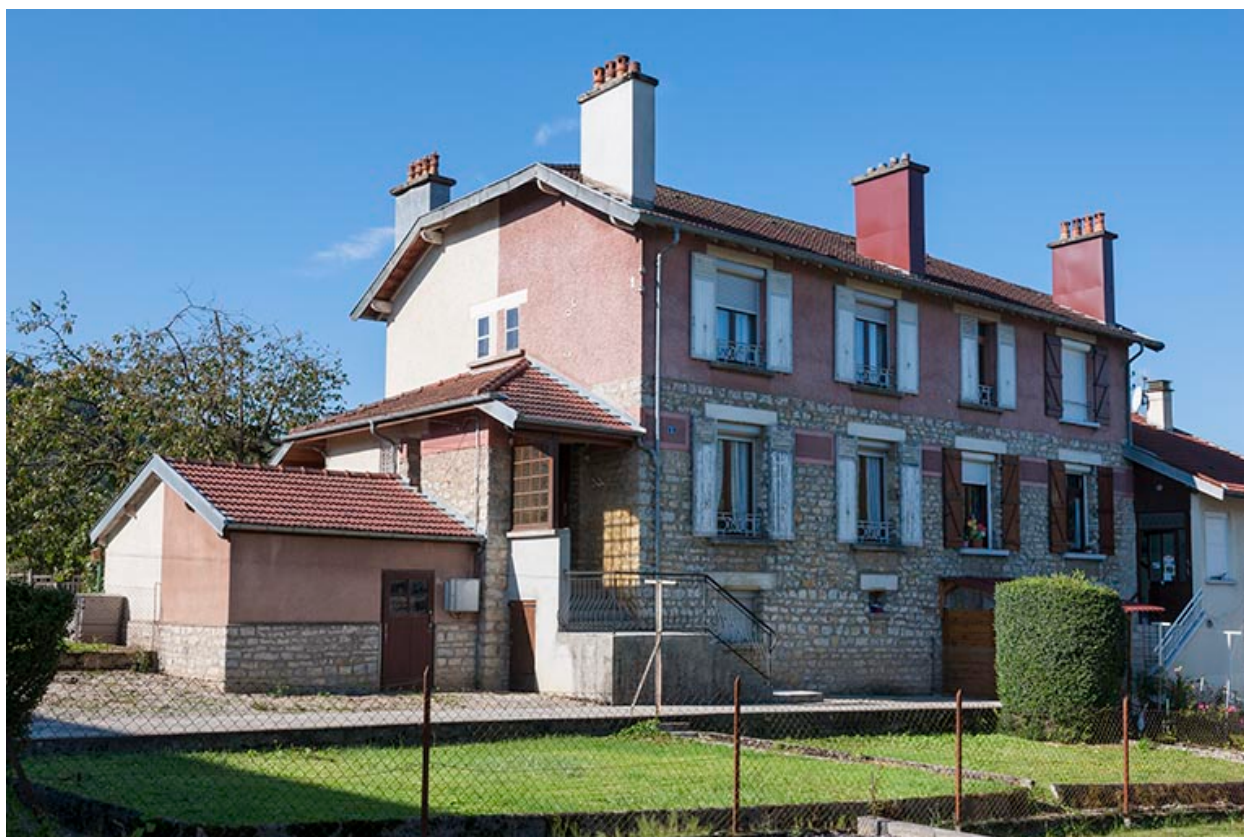
Maison à quatre logements. Vue trois quarts.
