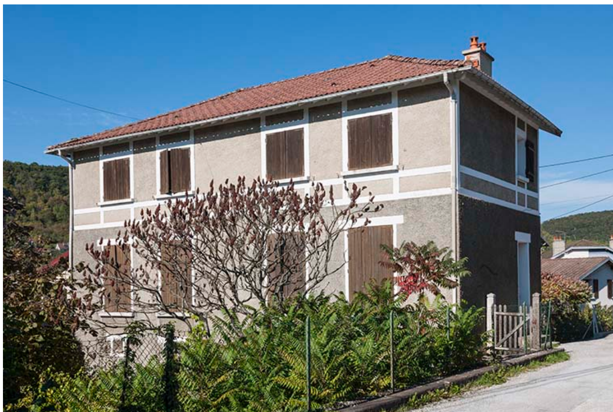
Façade postérieure d'une maison de célibataires.
