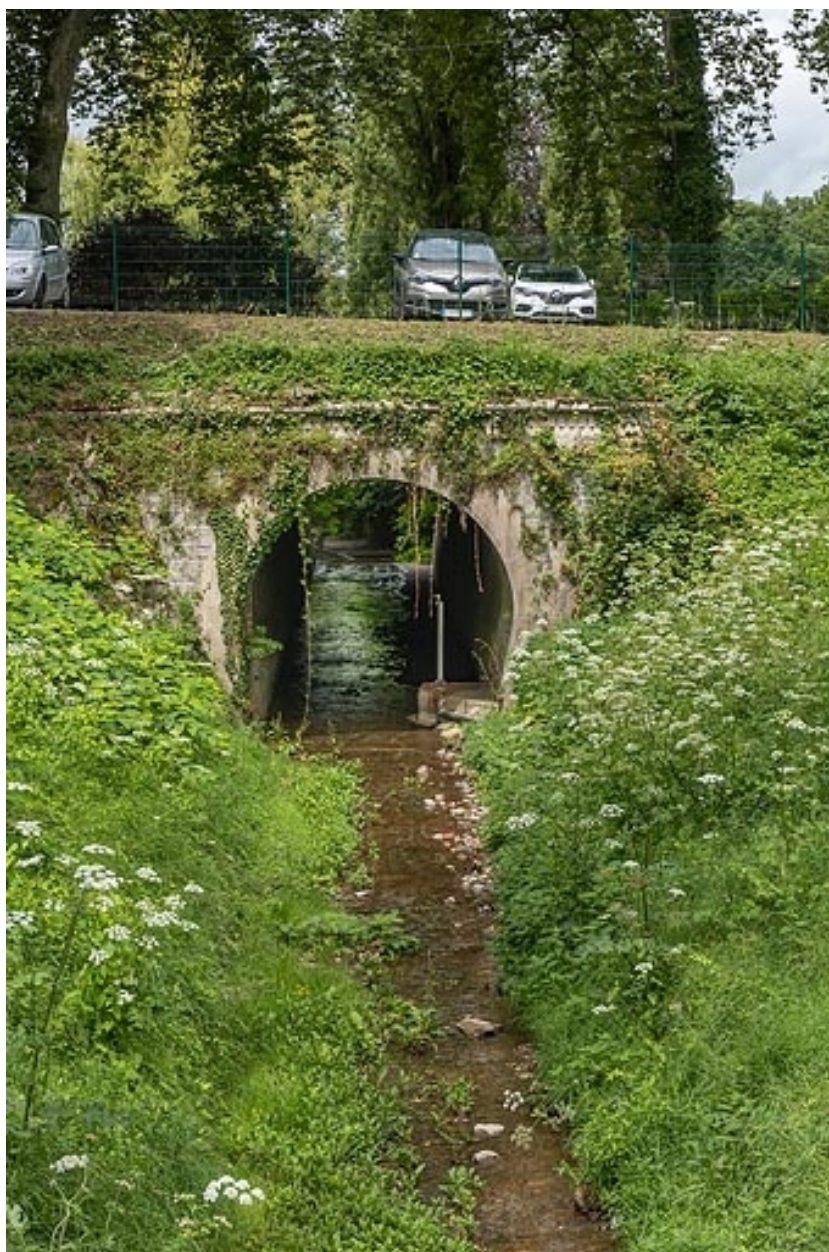
Tunnel du Borne sous l'allée d'Aligre.
