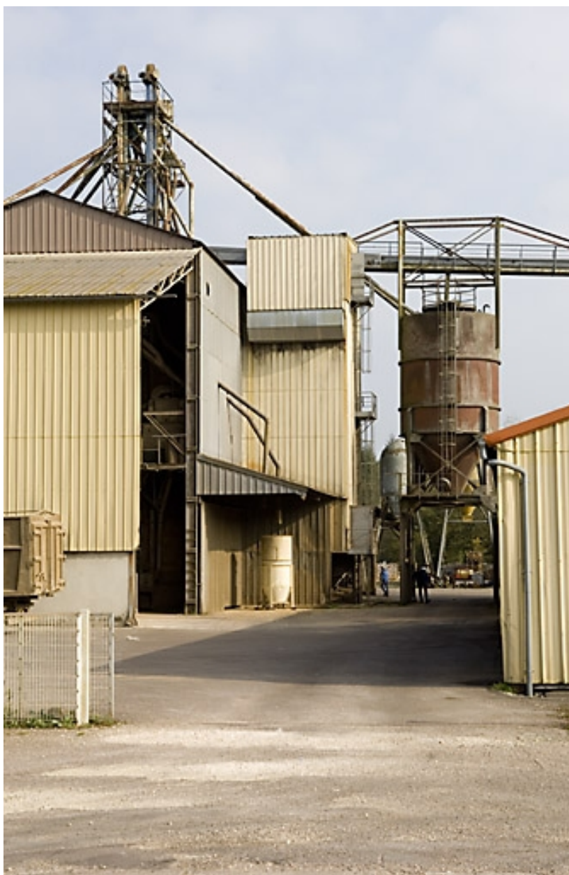
Silos et système de transport des céréales.
