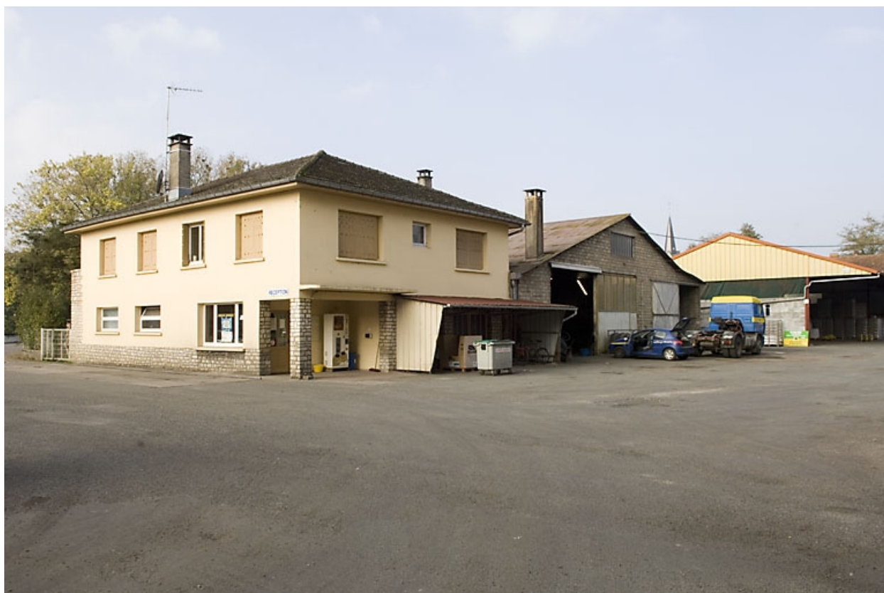
Logement et atelier de réparation depuis la cour.
