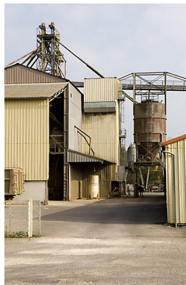
Silos et système de transport des céréales. Phot. Jérôme Mongreville IVR43_20077000544NUCA
