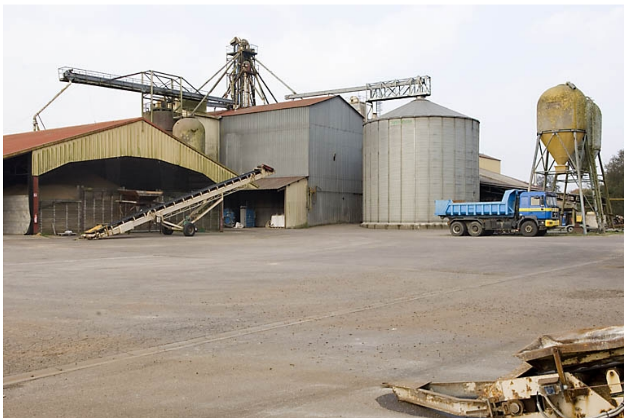
Silos et entrepôts industriels depuis l'arrière.
