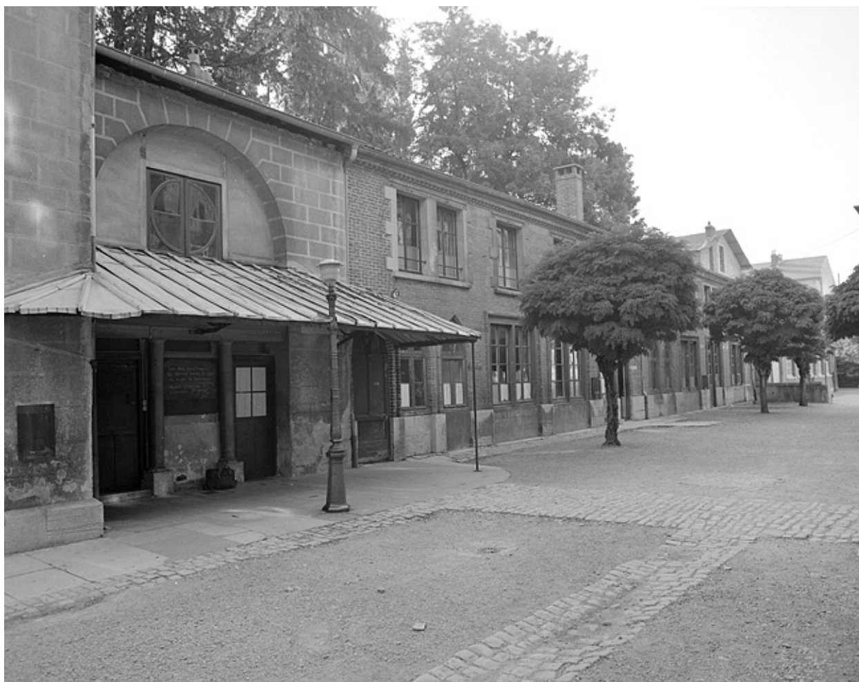
Bâtiment annexe, vue d'ensemble.
