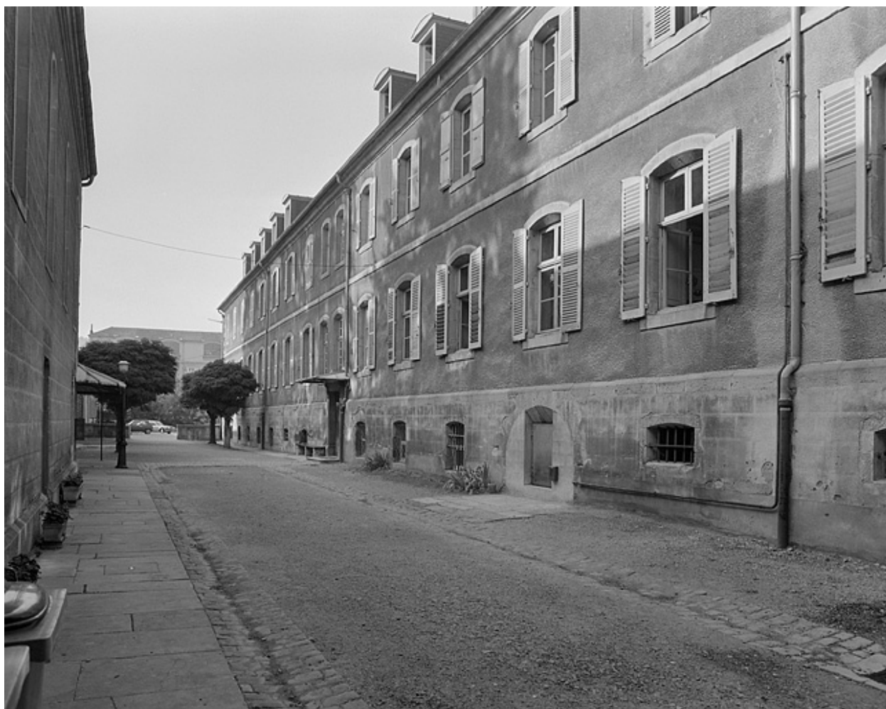
Bâtiment principal, façade sur la cour.
