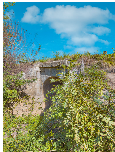
Le ponceau avec ses murs en aile, côté Saône. Phot. Thierry Kuntz IVR26_20197100515NUC4A
