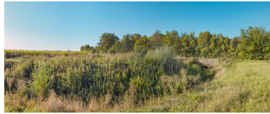
Le ponceau dans son environnement.
