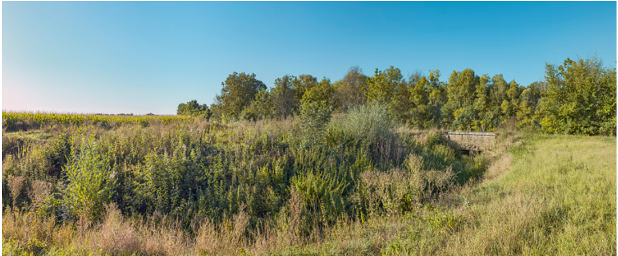
Le ponceau dans son environnement.
