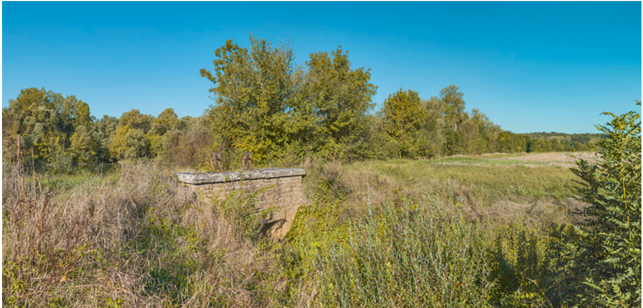
Le ponceau dans son environnement.
