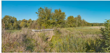
Le ponceau dans son environnement.
