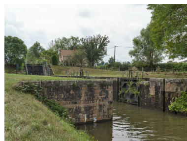
Le second sas, vu d'aval. Phot. Pierre-Marie Barbe-Richaud IVR26_20175800314NUC2A
