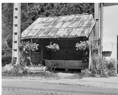
Réservoir situé rue du Vivier. Phot. Jérôme Mongreville IVR43_20003900223X
