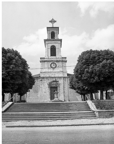
Extérieur : face antérieure. Phot. Yves Sancey IVR43_19752500224X
