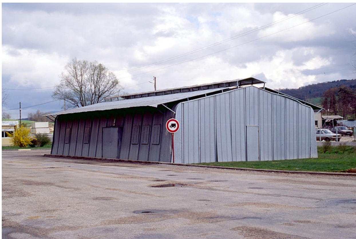
Entrepôt industriel (E).
