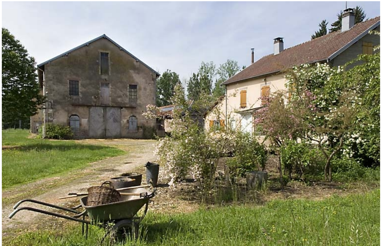
Atelier de filature et logement depuis l'est.
