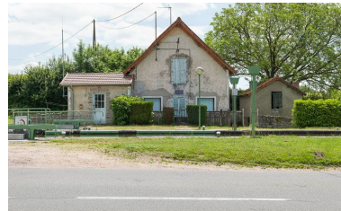
Vue de face de la maison éclusière.
