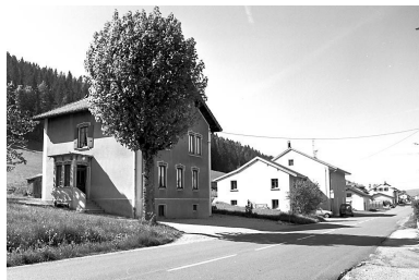
Vue de situation. Phot. Jérôme Mongreville IVR43_20013900447X
