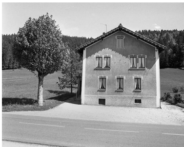
Façade postérieure sur rue. Phot. Jérôme Mongreville IVR43_20013900449X
