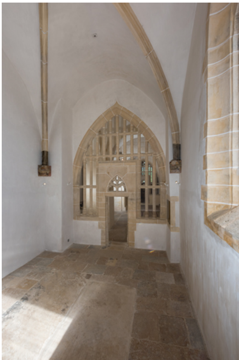
Vue intérieure de chapelle vers le nord.
