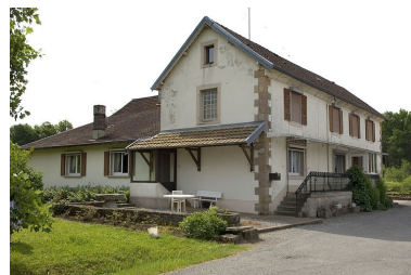
Le logement du moulin. Phot. Jérôme Mongreville IVR43_20067000535NUCA
