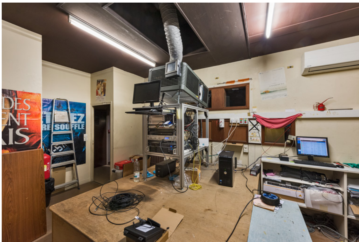
La cabine de projection en 2022, avant transformation.
