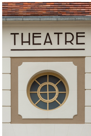
Façade antérieure : oculus. Phot. Pierre-Marie Barbe-Richaud IVR26_20248900068NUC4A
