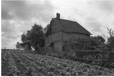
Vue d'ensemble. Phot. Bernard Lardière IVR43_19817000265Z
