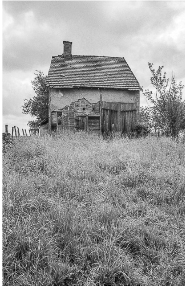
Vue de face. Phot. Bernard Lardière IVR43_19817000266Z
