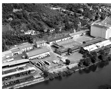
Usine à papier de la société des Papeteries Bisontines, Besançon (avenue De Chardonnet) : vue plongeante.
