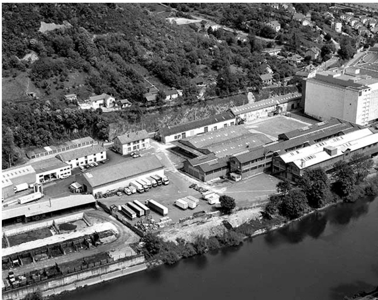
Usine à papier de la société des Papeteries Bisontines, Besançon (avenue De Chardonnet) : vue plongeante.
