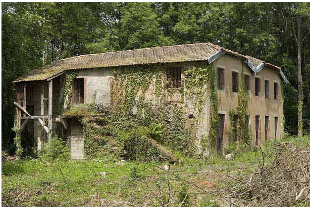
Moulin à papier Desloye puis Terré, Plancher-Bas.
